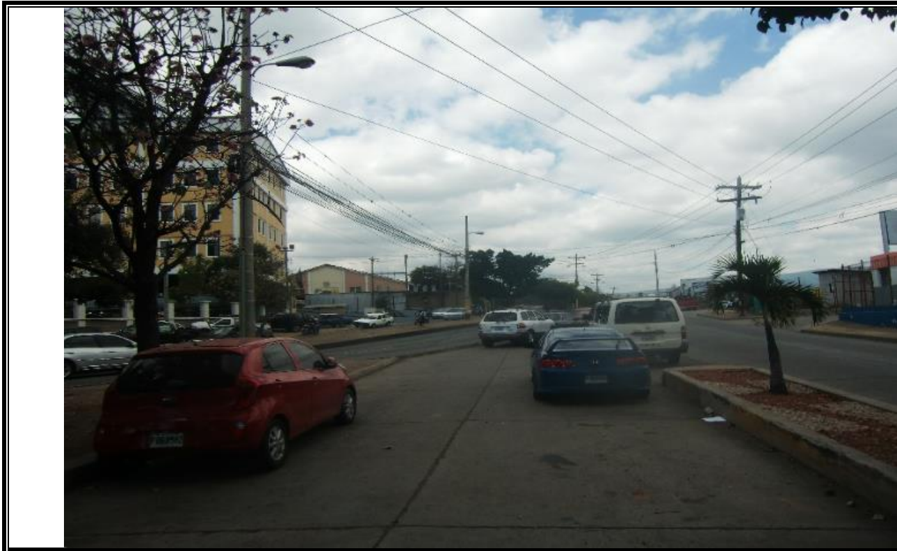
No. 6.3 Vista panorámica mostrando el cruce entre el Bulevar Santa Cristina y el Bulevar Kuwait. PROYECTO: Paso a Desnivel Bulevar Kuwait-Bulevar Santa Cristina Fecha: Abril. 2016
