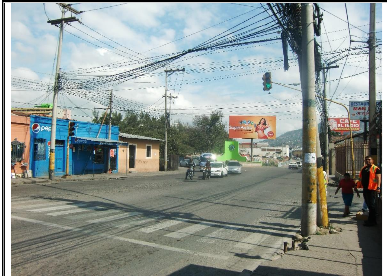
No. 5.3 Vista panorámica de la intersección Blv. Comunidad Económica Europea y Puente Guacerique. PROYECTO: Estudio y Diseño Paso a Desnivel Guacerique Fecha: Abril. 2016
