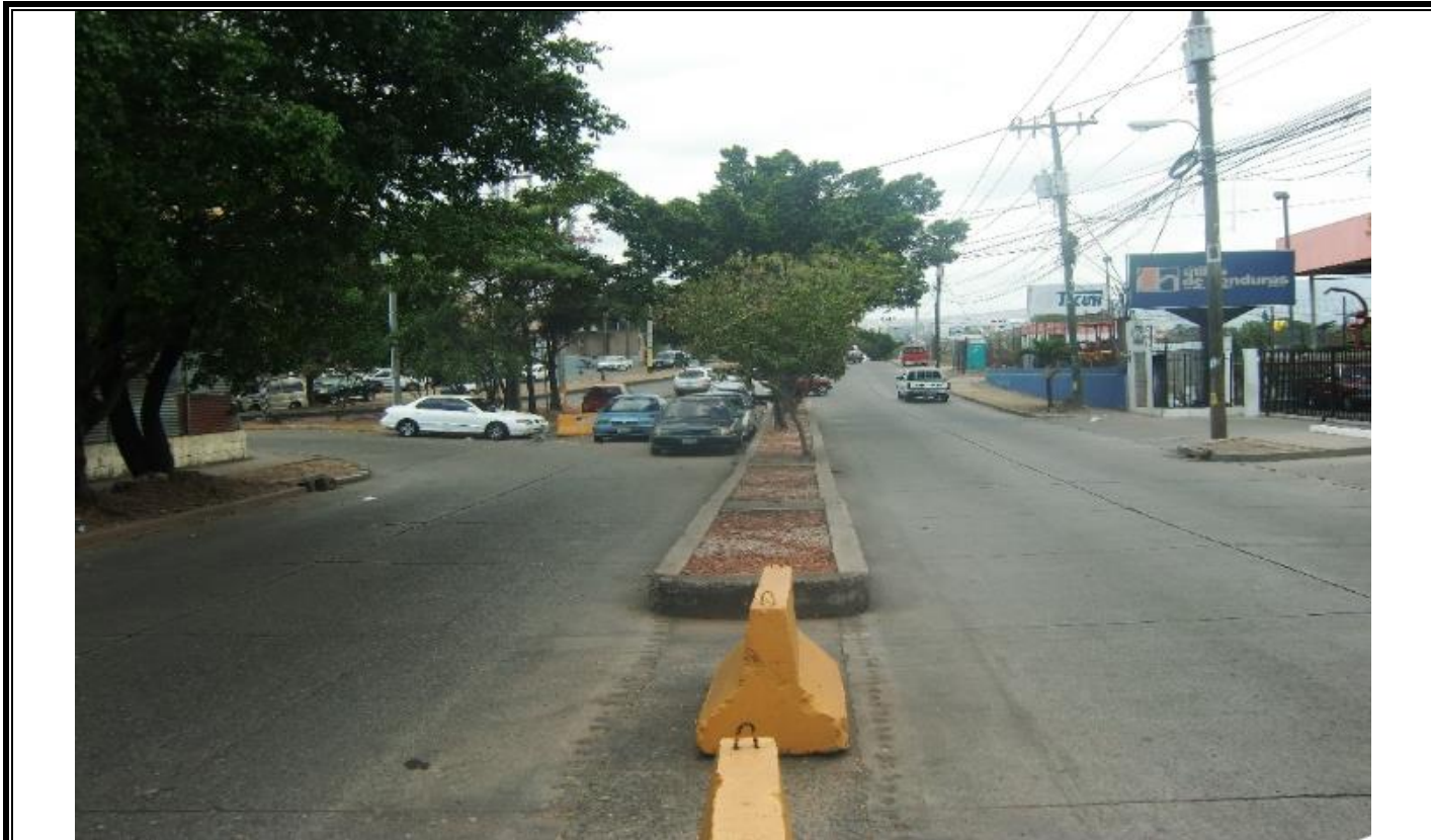
No. 6.2 Vista panorámica mostrando el cruce entre el Bulevar Santa Cristina y el Bulevar Kuwait. PROYECTO: Paso a Desnivel Bulevar Kuwait-Bulevar Santa Cristina Fecha: Abril. 2016
