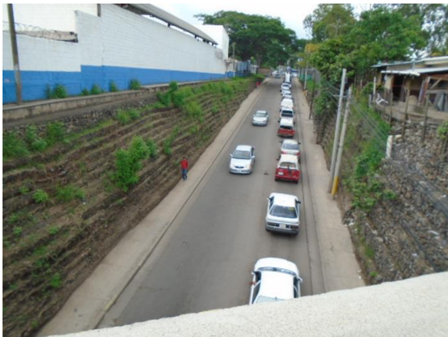
Muro de gaviones en colectora Kennedy frente a Planta Procesadora LACTHOSA SULA
