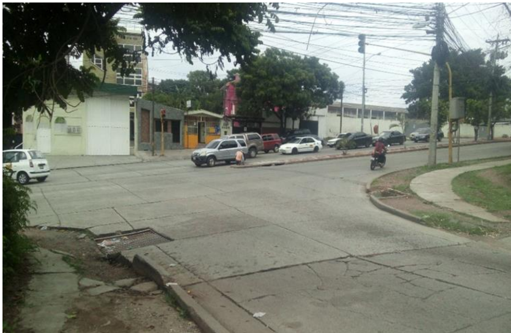
Esquinas a modificar en calle de acceso a Col. Víctor F. Ardón
