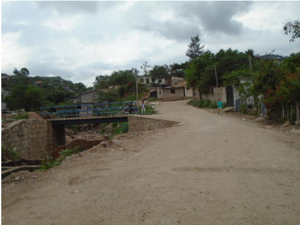
Calle a pavimentar en Col. Los Pinos
