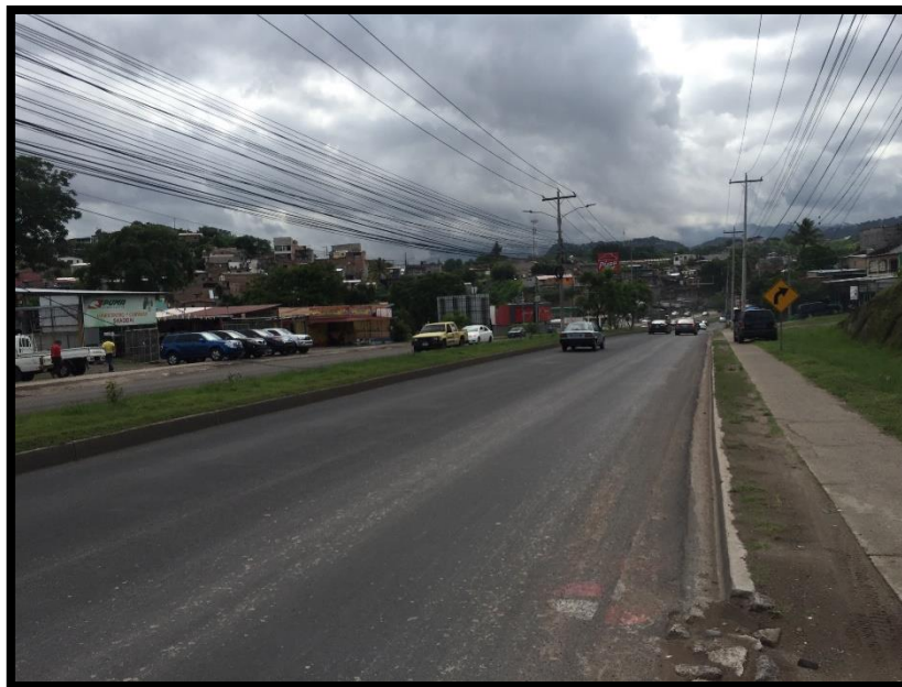
Vista de ampliación del tercer carril del Anillo Periférico en La Cañada.
