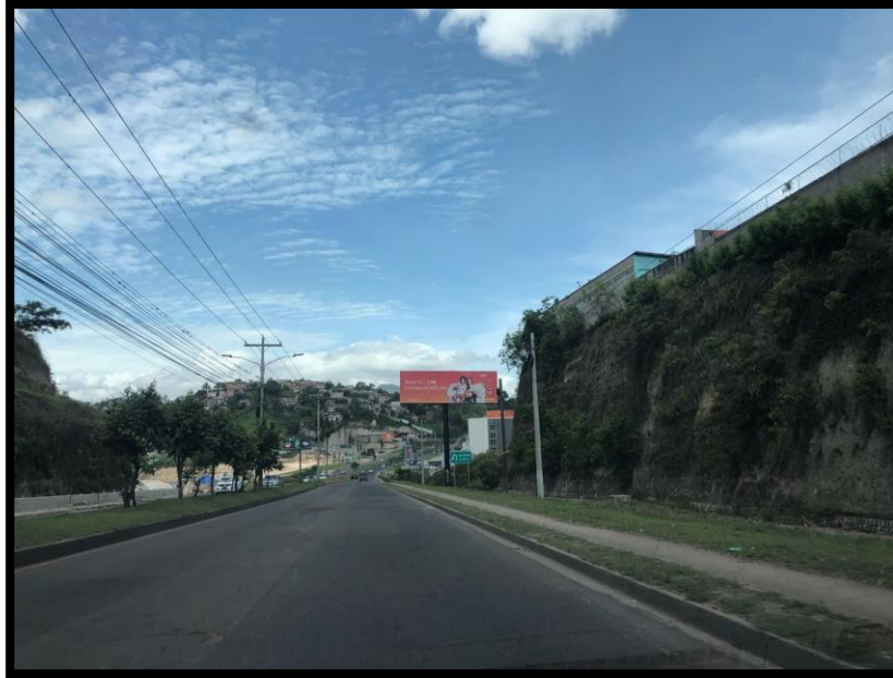
Inicio del Proyecto de Ampliación del tercer carril del Anillo Periférico, tramo desvío Loarque – Puente Río Grande
