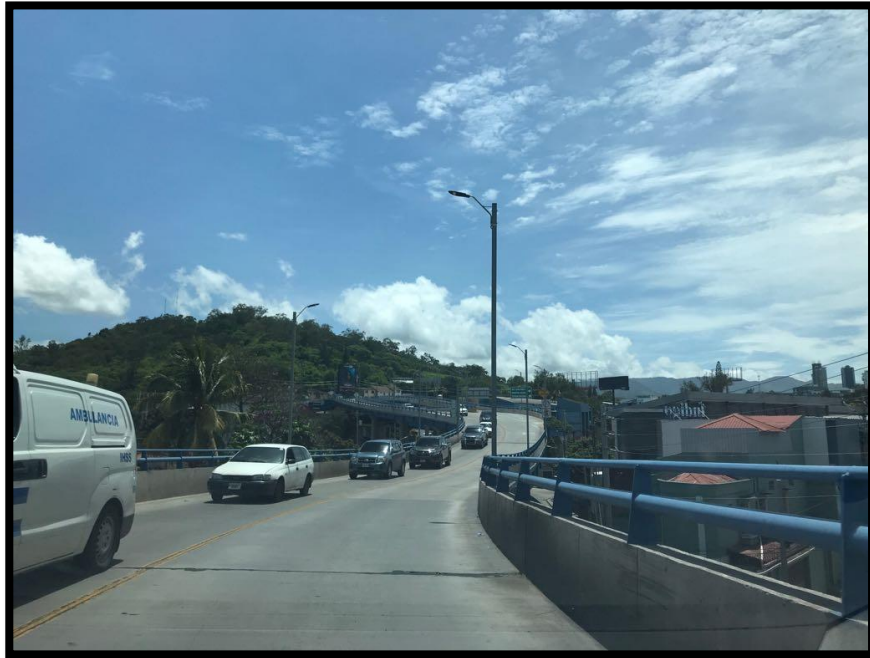
Vista de tramo a ampliar del Puente Vía Rápida Kuwait-José Cecilio del Valle
