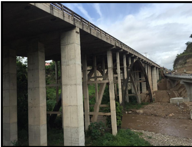
Vista de la Sub estructura del Puente a Ampliar
