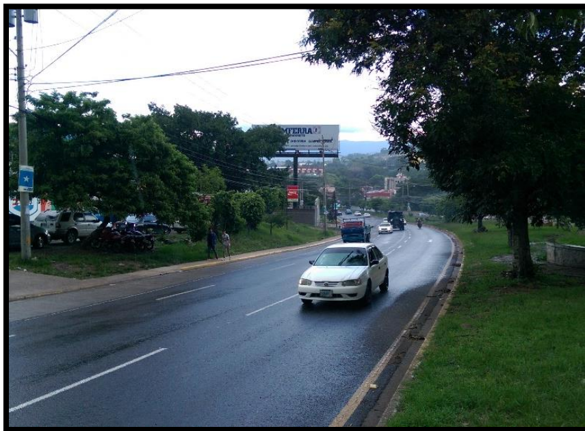
Carril Anillo Periférico dirección de Suyapa a Loarque donde se hará conexión Blvd Venecia
