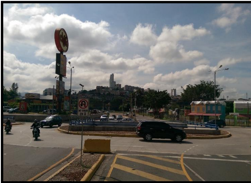
Vista de Rotonda donde ira el tercer nivel sobre Bulevar Centroamérica
