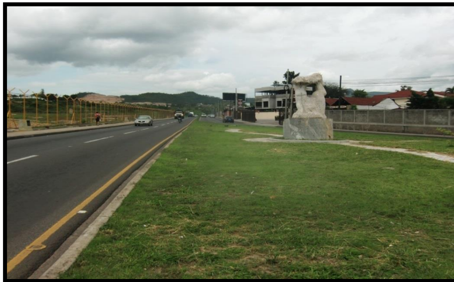
No. 1 Proyecto: Paso a Desnivel Acceso a Col. América- Bulevar Comunidad Económica Europea. Fotografía mostrando el Anillo Periférico
