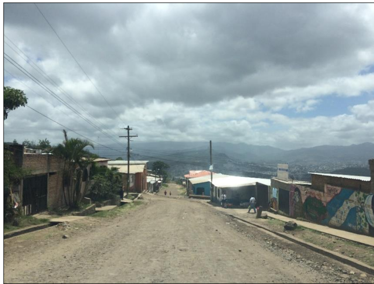
Colonia Nueva Capital a la altura de la Escuela
