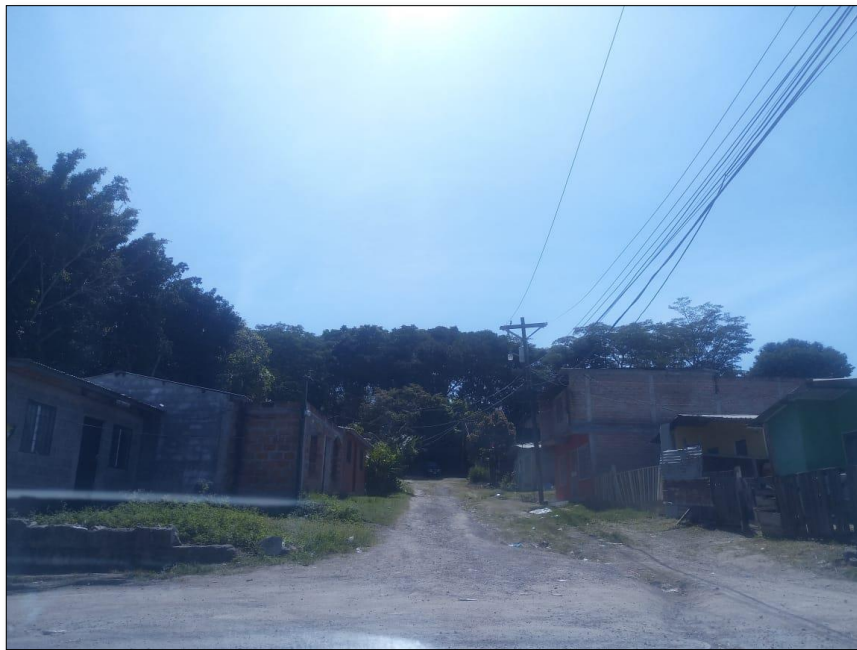
En la imagen se muestra las condiciones de las diferentes calles en la colonia Villa Cepudo
