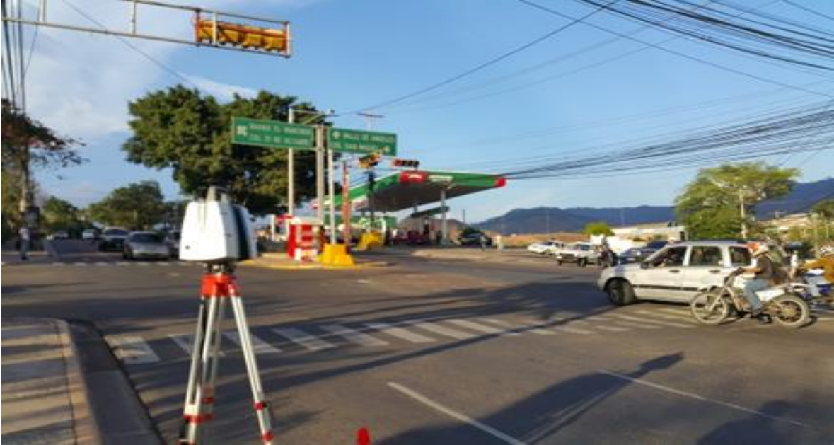
Vista de intersección Col San Miguel y Col. 21 de Octubre, donde actualmente existe un semáforo. Se observa también el tráfico en sentido desde el Anillo Periférico hacia Bulevar Los Próceres y viceversa
