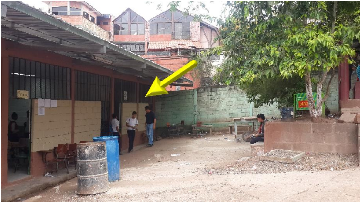
Demolición y reubicación de aula existente
