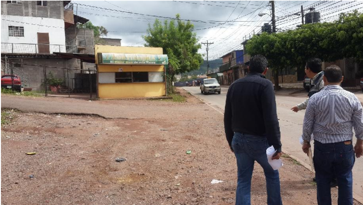
Afectaciones dentro del derecho de vías
