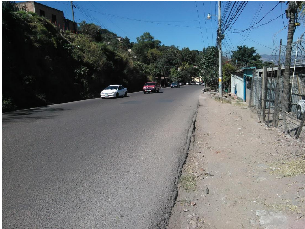
FOTO 3. VISTA ACTUAL DE CARRETERA
