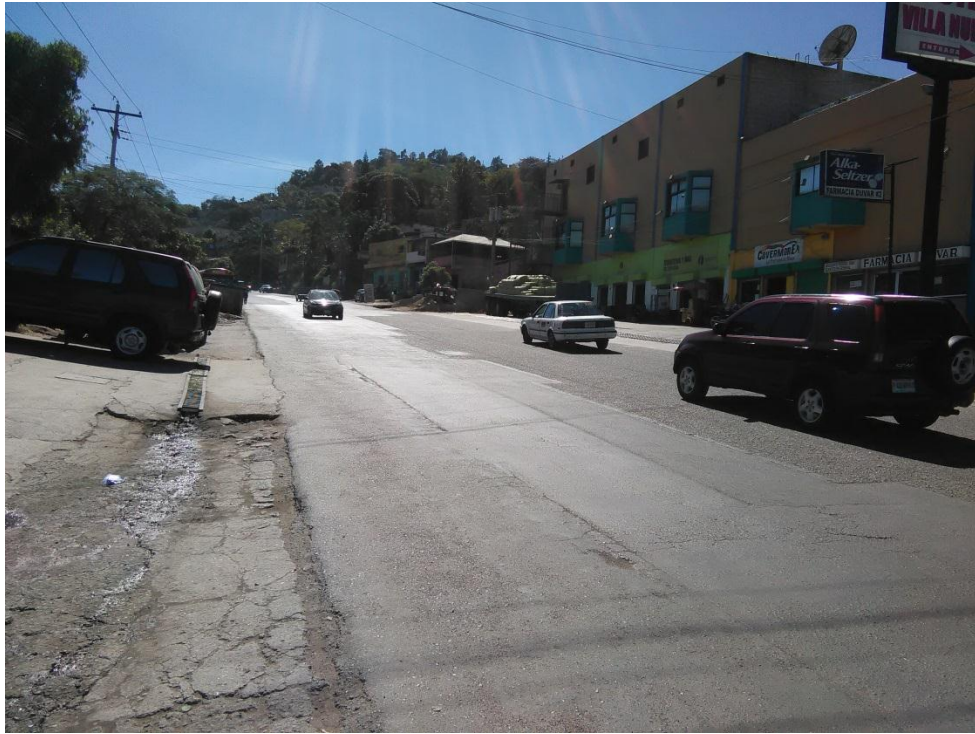
FOTO 4. VISTA DE CARRETERA A AMPLIAR
