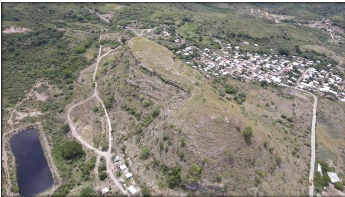
Vista de zonas altas que colindan con el proyecto localizados en el sector norte
