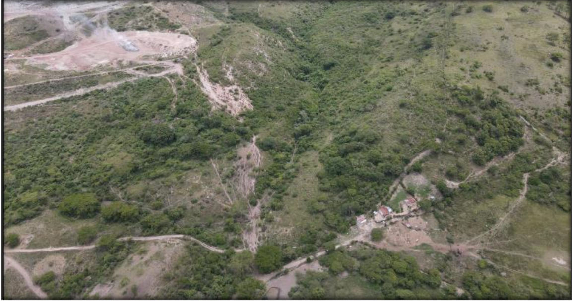
Vista cenital del sector noroccidental del predio
