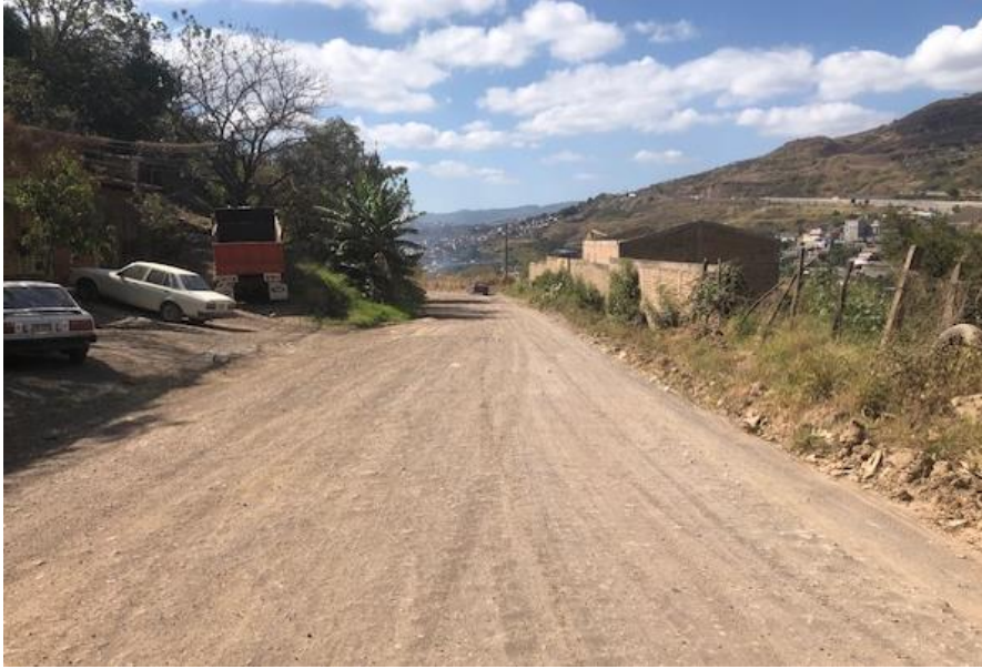
Estación 2+000, tramo en mal estado a pavimentar.
