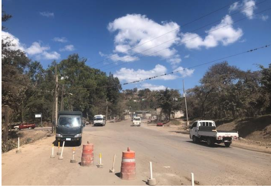
Intersección Salida a Olancho; se diseñará una solución en conjunto con el proyecto de la SIT.
