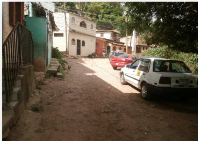
FOTOGRAFIA DE MURO EN PRIMERA CALLE.
