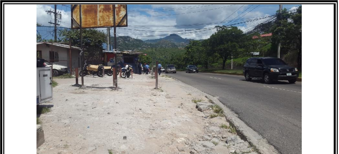
No.2 Descripción: Ampliación de bulevar
