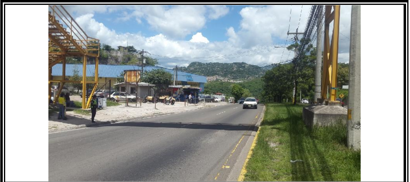
No.1 Descripción: Ampliación de bulevar
