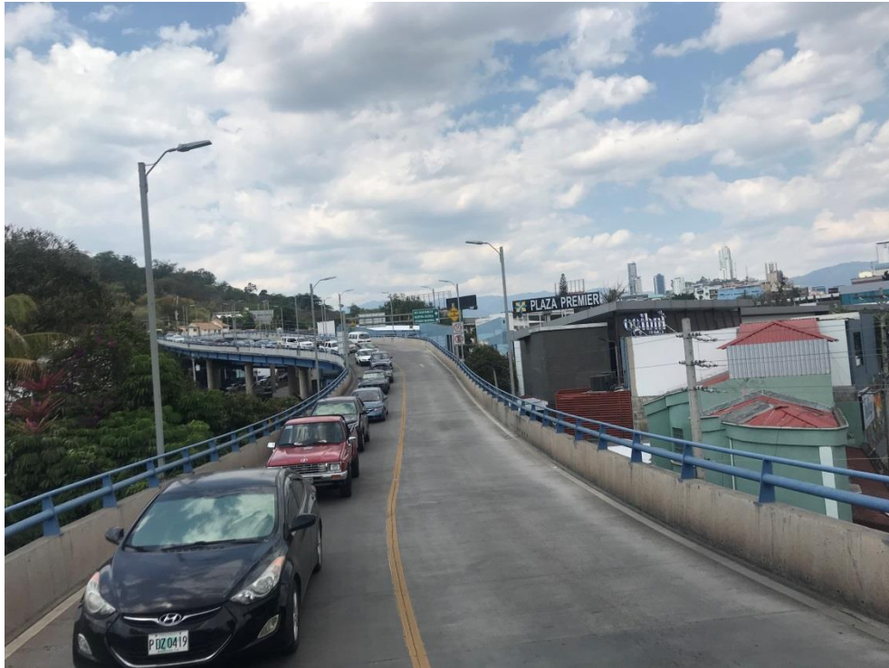
Vista de tramo a ampliarse en sentido Sur – Norte
