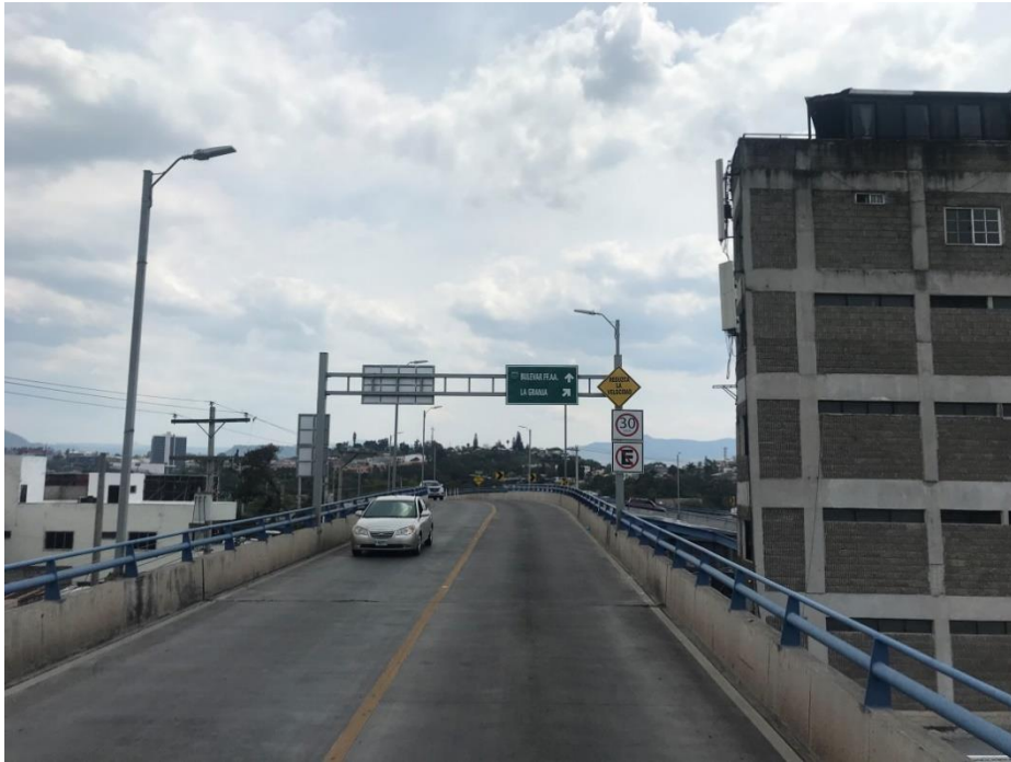
Vista de tramo a ampliarse en sentido Norte - Sur
