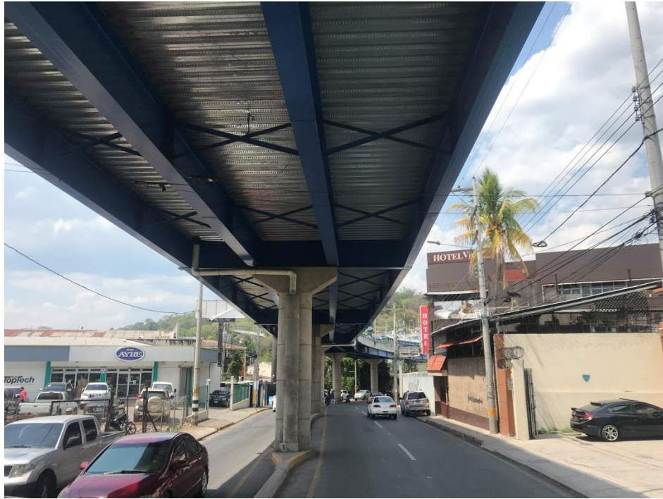
Imagen de desde la parte inferior del tramo a ampliarse
