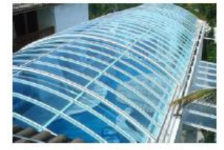
Cubierta de policarbonato
