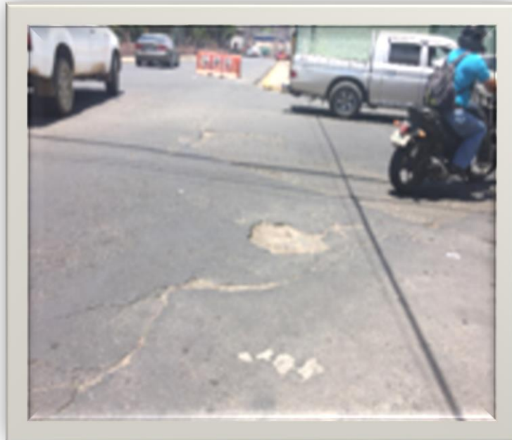
En la imagen se muestra como referencia zonas donde se realizarían trabajos de bacheo para mejorar la circulación vehicular
