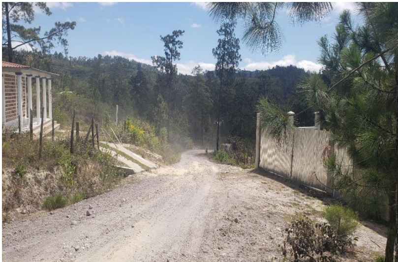
Vista estado actual de calle a conformar.
