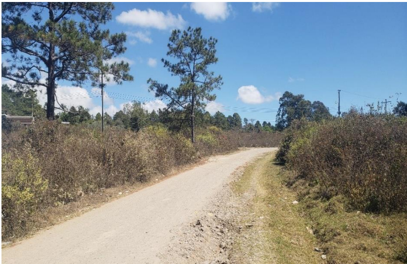
Vista estado actual de calle a conformar.
