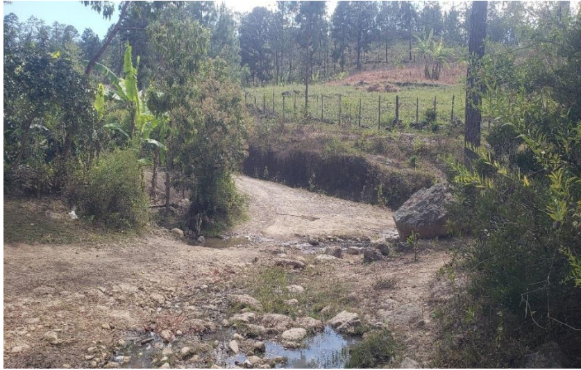
Vista estado actual de calle a conformar.
