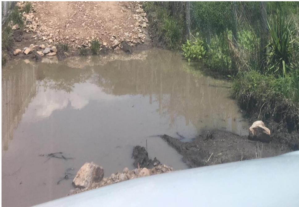
VISTA DE TRAMO DE CALLE A REPARAR
