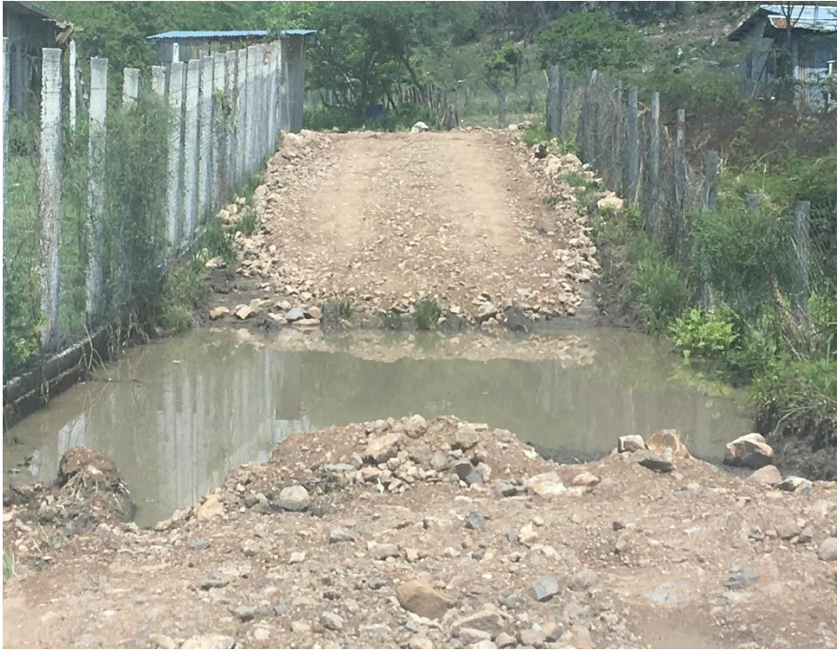
VISTA DE TRAMO DONDE SE COLOCARA ALCANTARILLA PVC DE 24" DOBLE PARED
