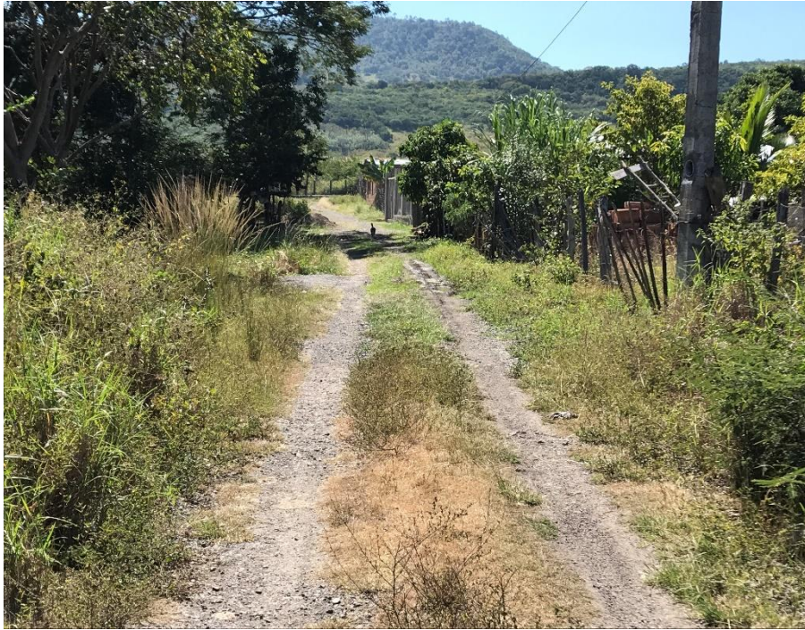
VISTA DE LAS CONDICIONES EN QUE SE ENCUENTRA LA CALLE A BALASTAR
