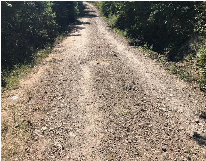
VISTA DE CALLE A CONFORMAR Y BALASTAR
