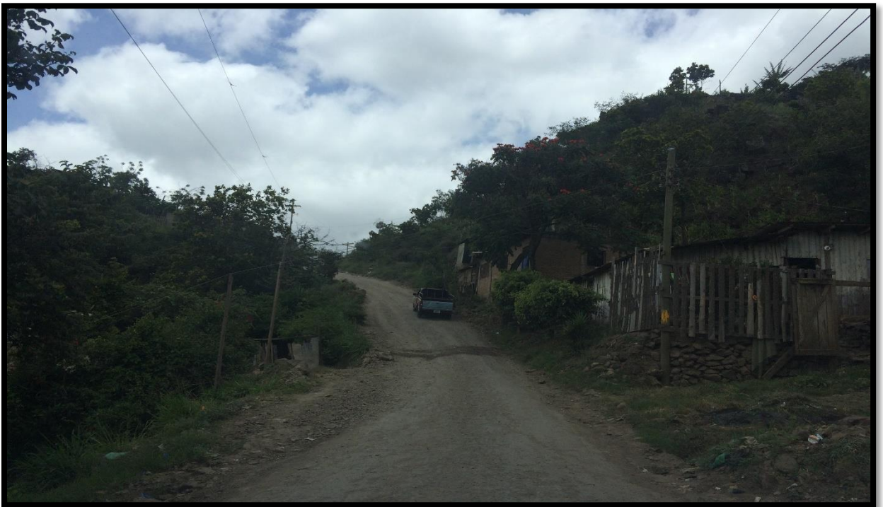
Vista del tramo final de la reparación
