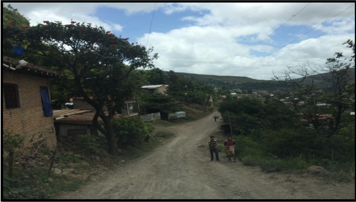
Vista del tramo inicial a reparar colonia Ulloa
