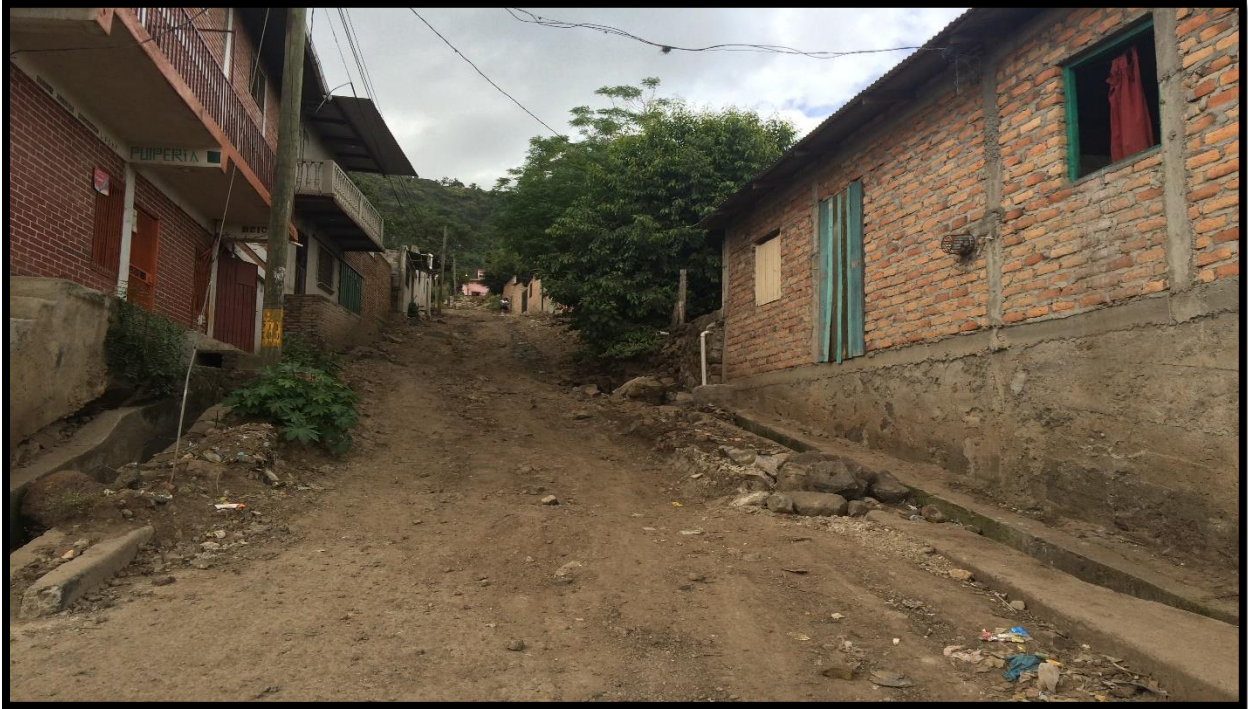
Vista del tramo donde se construirán las huellas vehiculares
