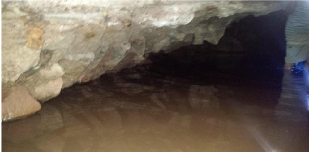
En la imagen se muestra la zona socavada bajo los muros del embaulado existente
