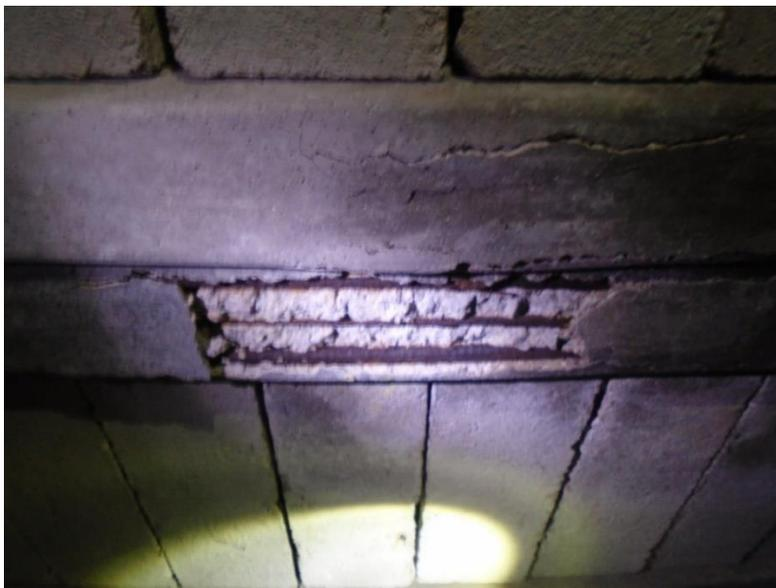
La imagen muestra el sistema de losa y el estado actual de algunas de las vigas que la conforman, en donde es necesario recubrir el acero con mortero para evitar una falla en la misma.
