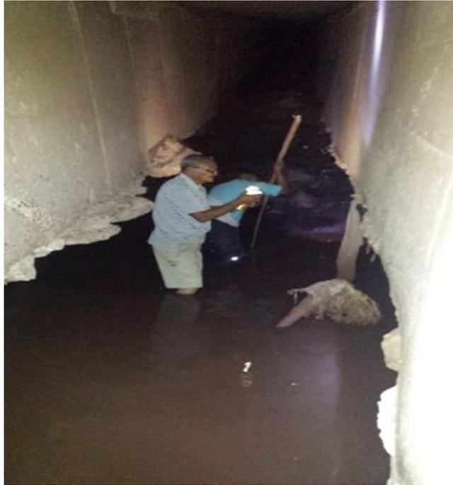
En la imagen se observa el tramo del embaulado socavado, en donde se colocará concreto ciclópeo. Previo a la colocación del concreto será necesario bombear el agua en este tramo para poder realizar las diferentes obras.
