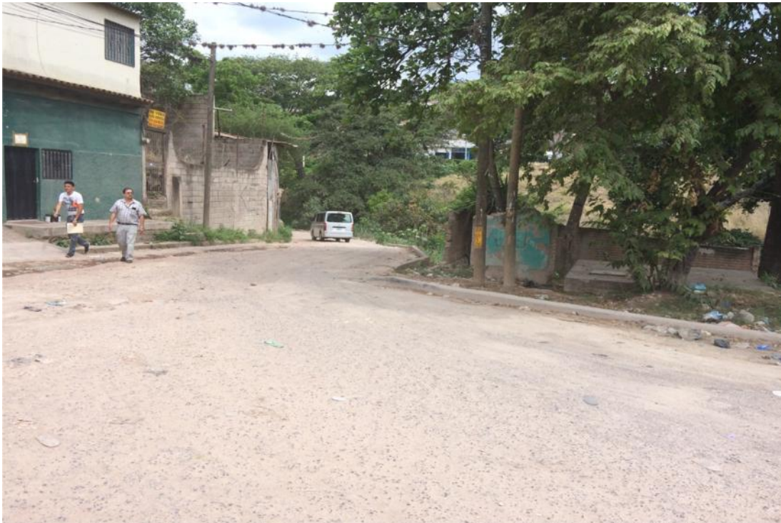
VISTA DEL FINAL DEL TRAMO A REPARAR
