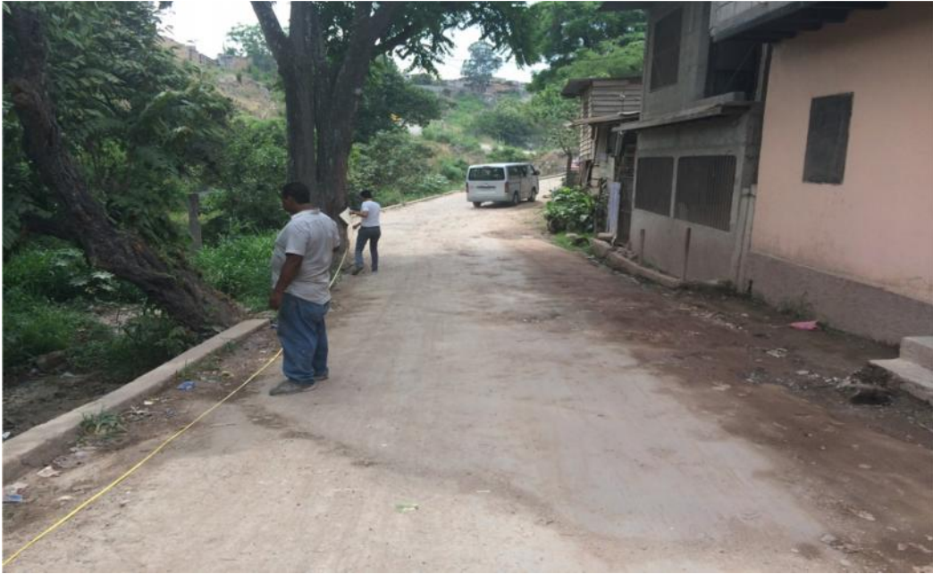
VISTA DE LA ZONA DONDE SE CONSTRUIRA EL MURO PARA ESTABILIZAR LA CALLE
