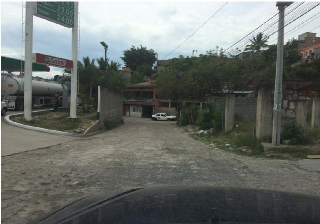
VISTA DEL INICIO DEL TRAMO A PAVIMENTAR FRENTE AL ANILLO
