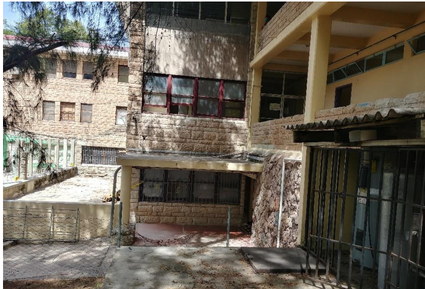
Vista de losa de concreto donde se instalará el tanque de agua de 1750 litros
