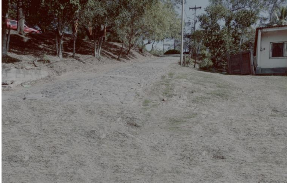
Se muestra la erosión ocasionada por la escorrentía en tiempo de lluvia
