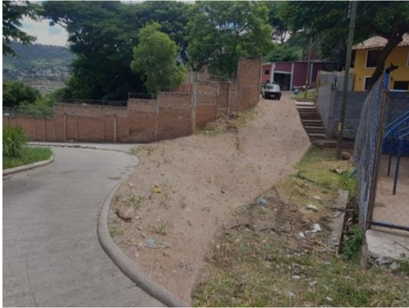
Se muestra el deterioro de la calle y la cuneta que no tiene salida
