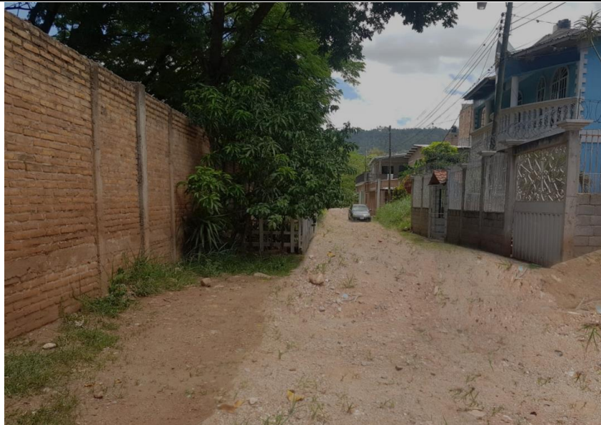
Se puede observar el mal estado de la calle a adoquinar.
