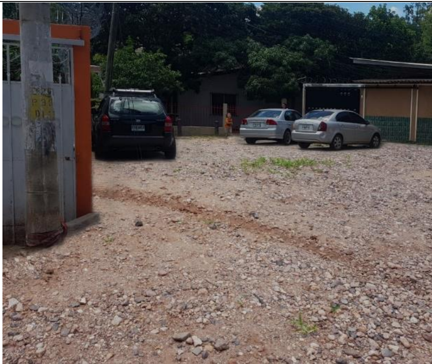
Se puede observar el mal estado de la calle y estacionamiento a adoquinar.
