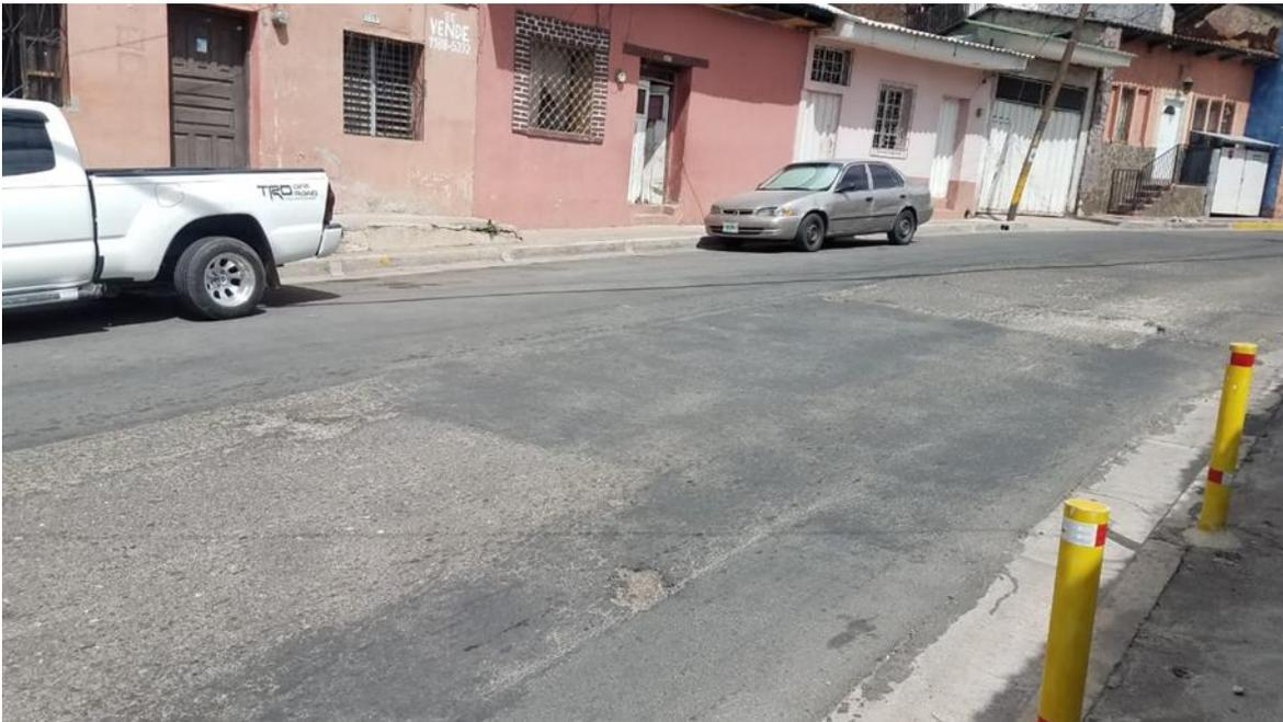
En la imagen se observa las fallas en la superficie de uno de los tramos a rehabilitar con mezcla asfáltica
