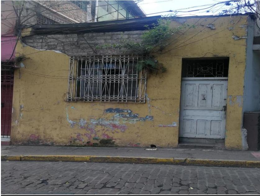
En la imagen se muestra una de las estructuras donde será necesaria la reconstrucción del repello, pulido y pintura
