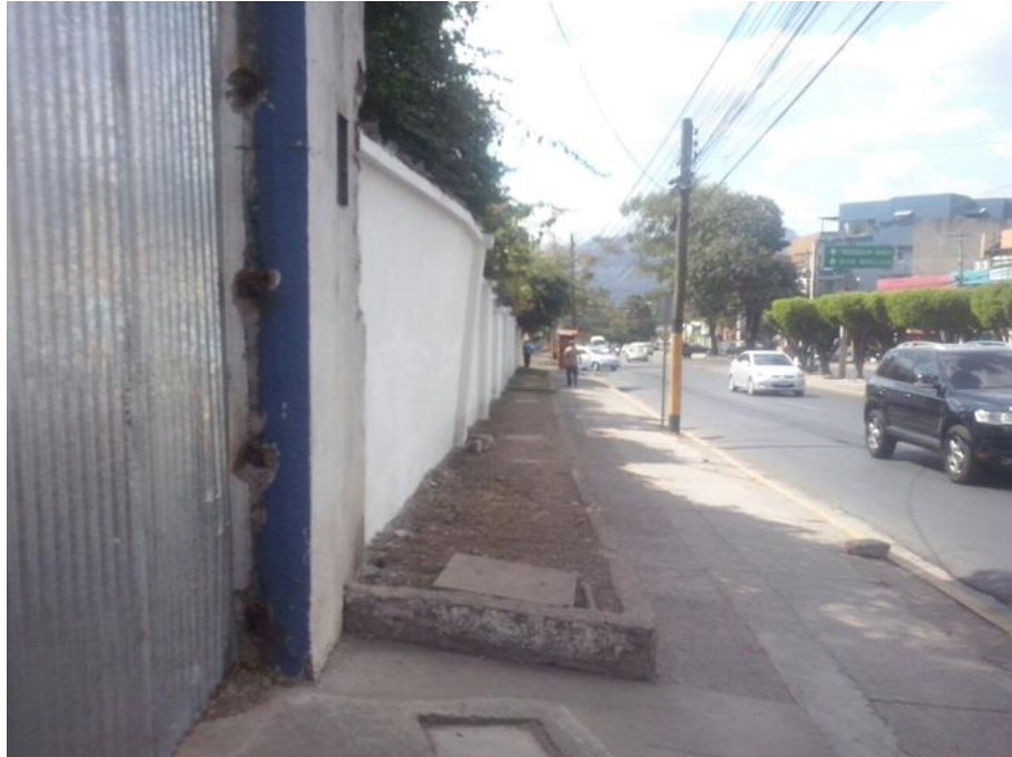
PANORAMA EN QUE SE HARÁ LA AMPLIACIÓN DE LA CALZADA
