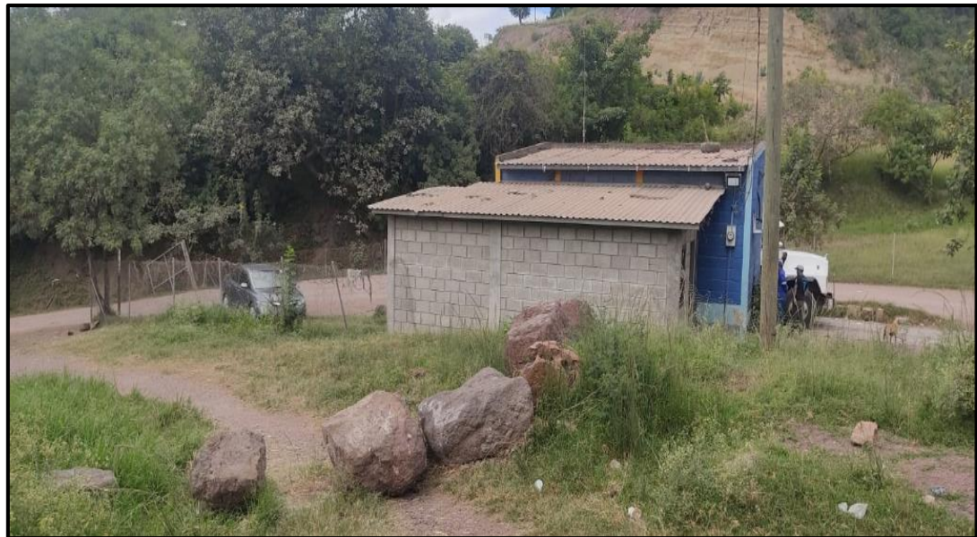
Sitio del emplazamiento de la nueva bascula
