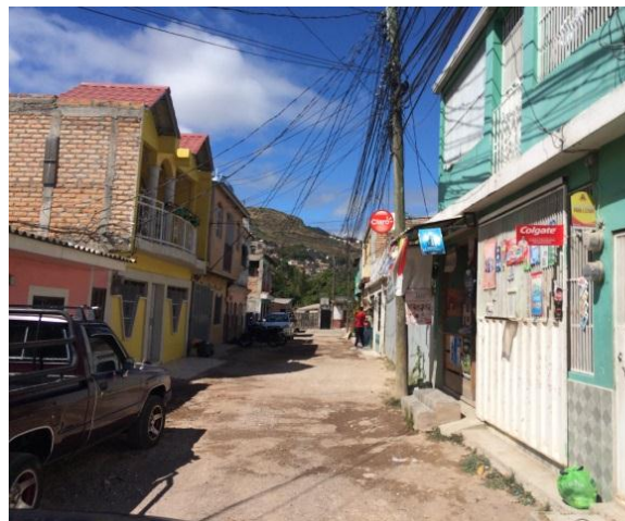
Se observa el ancho y el estado actual de la calle tramo #2.
