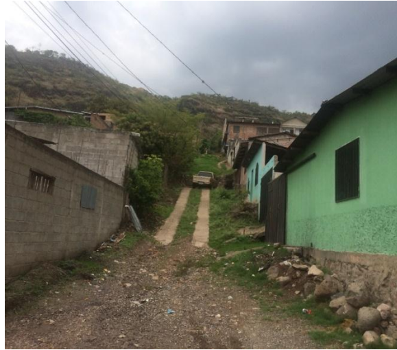
Final de calle en que se construirán huellas vehiculares.
