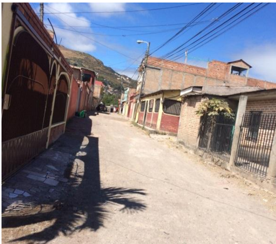
Se observa el ancho y el estado actual de la calle tramo #2.
