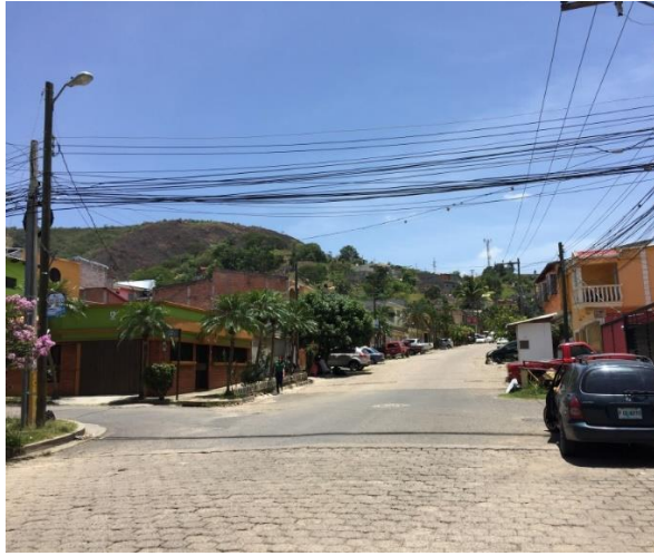
Final de obra a ejecutar.
