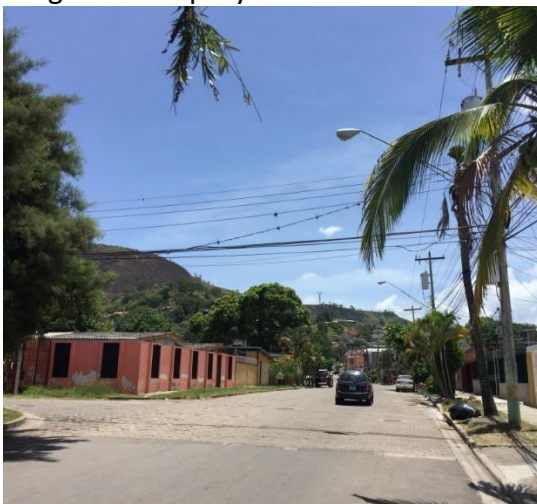
Vista de inicio de obra a ejecutar.
