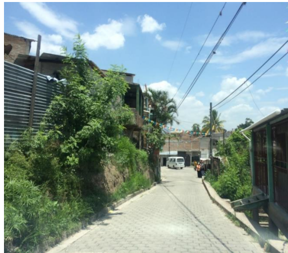
Final de calle a pavimentar en col. peña por bajo.
