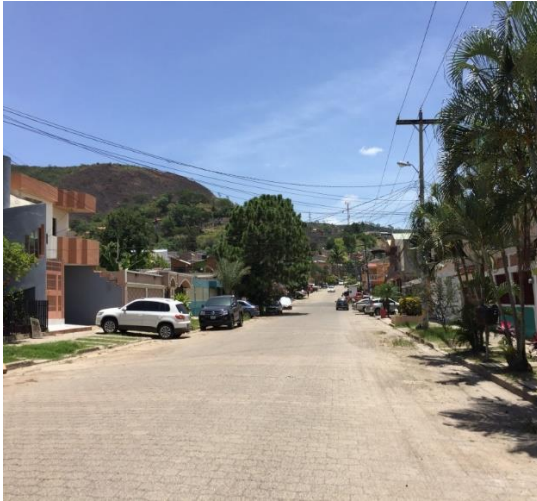
Vista de calle en que se ejecutará la obra.
