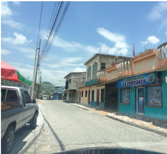
Vista de calle a pavimentar con concreto hidráulico
