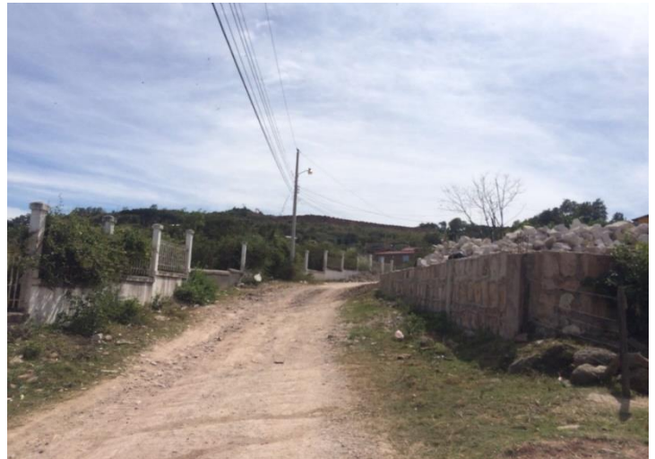
Vista de calle de terracería.
