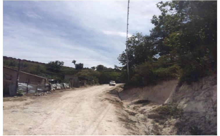
Malas condiciones de calle donde se construirán huellas.
