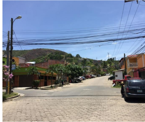
Final de obra a ejecutar.
