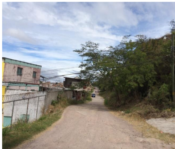
Vista de calle a pavimentar con concreto hidráulico.
