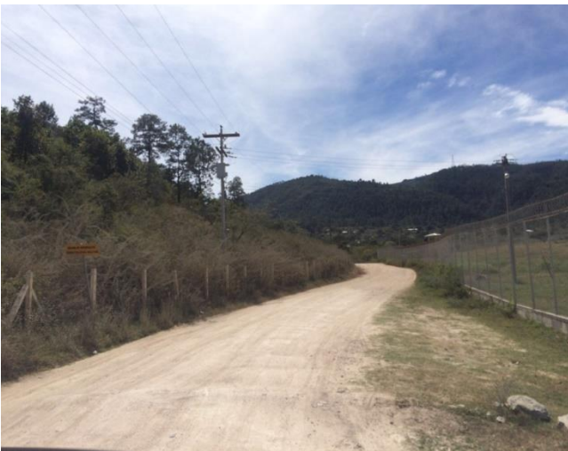
Calle a conformar y balastar.
