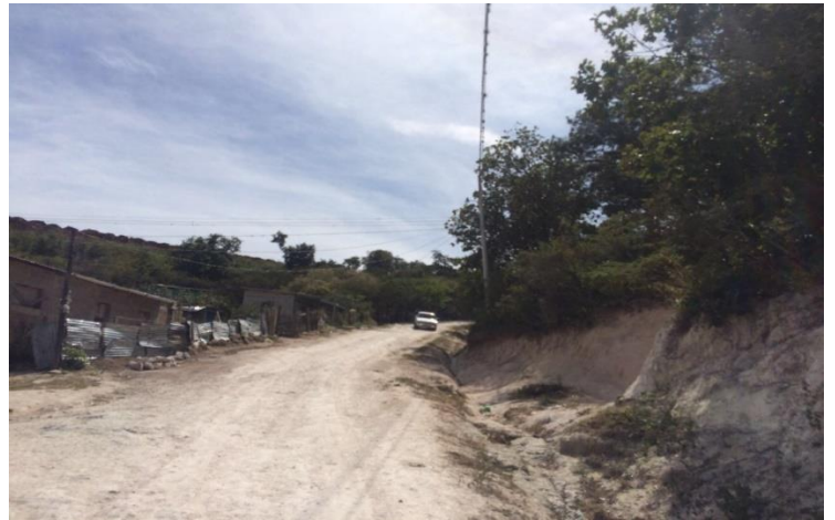
Malas condiciones de calle donde se construirán huellas.
