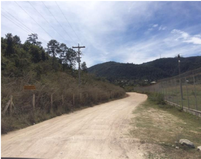
Calle a conformar y balastar.
