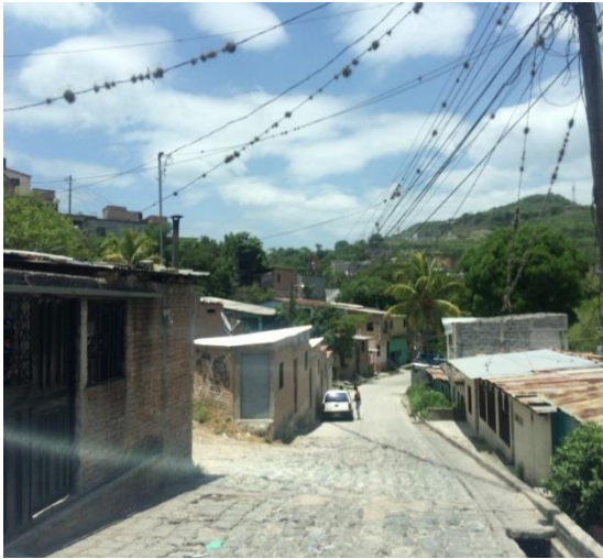
Inicio de calle a pavimentar con white topping.
