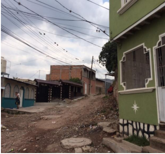
Vista panorámica de la calle a pavimentar.
