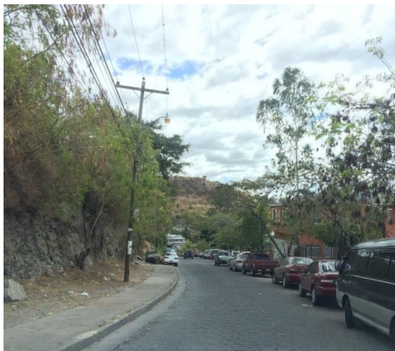
Vista del estado de los adoquines existentes.
