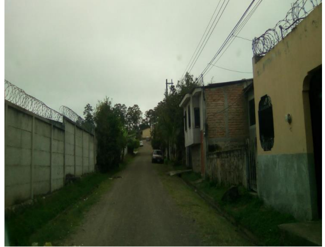
Vista de calle a pavimentar con concreto hidráulico.
