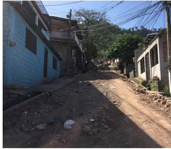
Vista panorámica de calle a pavimentar con concreto hidráulico
