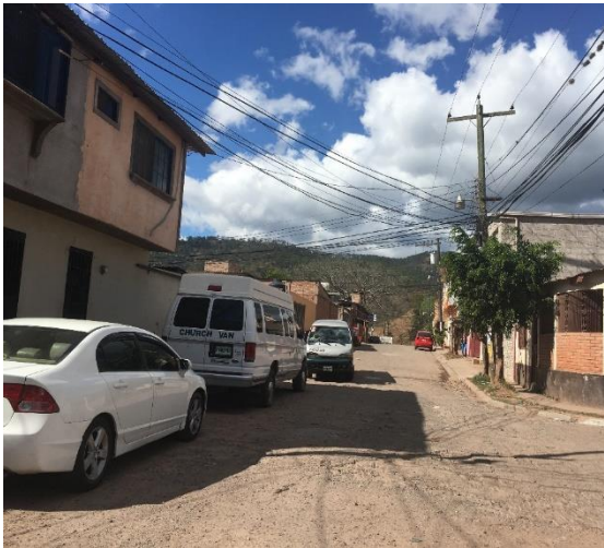
Panorama de la calle a pavimentar.
