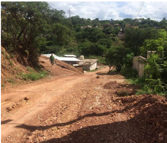
Foto #1 panorámica de calle.
