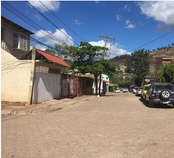
Vista de la calle donde se desmontará el adoquín.
