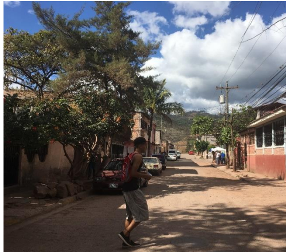
Vista de la calle a pavimentar con concreto hidráulico.
