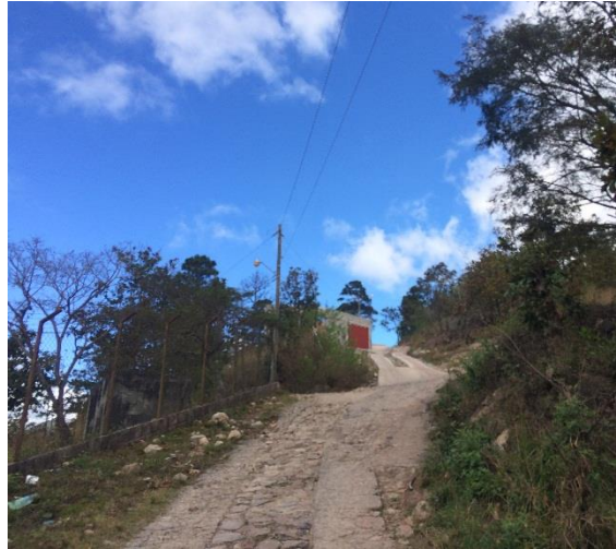
Huellas y emplantillado a demoler.
