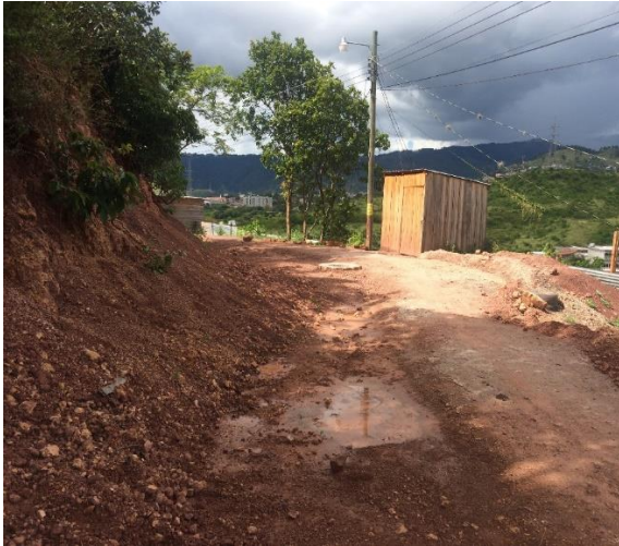
Foto #3 condiciones actuales de la calle a pavimentar.
