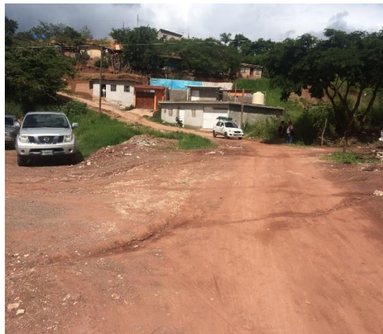
Foto #2 tramo de calle donde se colocara drenaje.
