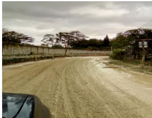
En la imagen se muestra un tramo intermedio de la calle a mejorar indicando el estado actual de la sub base existente.
