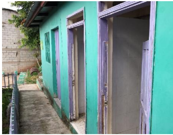
Area de baños y cocina a remodelar.
