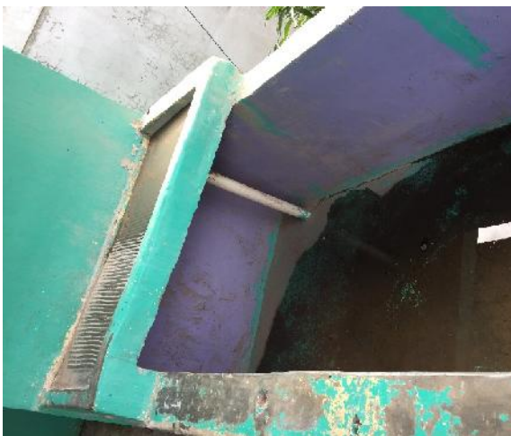
Pila a demoler.
