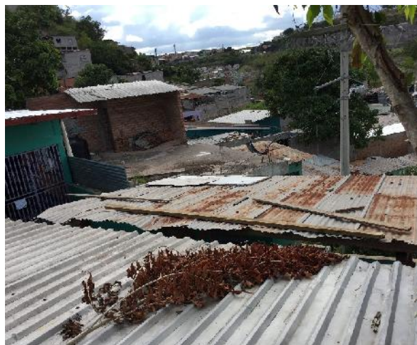
Vista de techos a desmontar en baños y pila.
