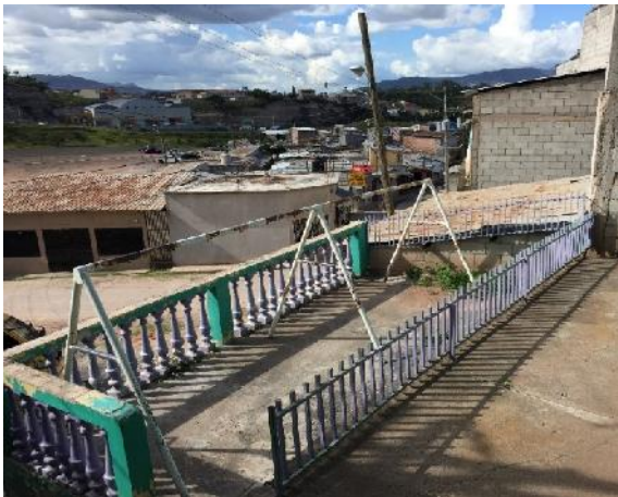
Pasamanos de concreto a demoler.
