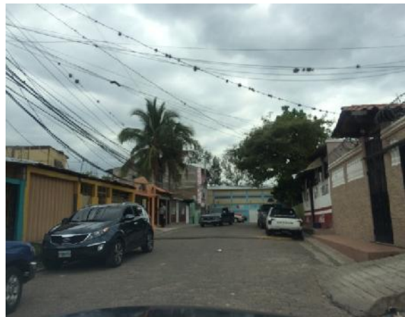
panorama de calle en que se desmontará el adoquín
