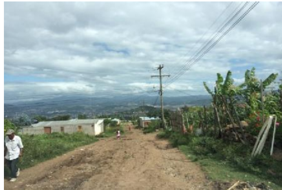
Tramo donde se construirán cunetas de mampostería
