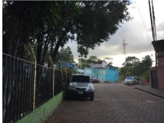
Estado Actual Del Adoquin Que Se Desmontara
