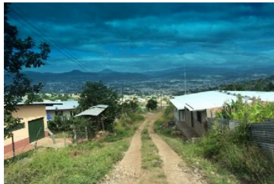
Vista de calle en colonia nueva capital donde se construiran cunetas
