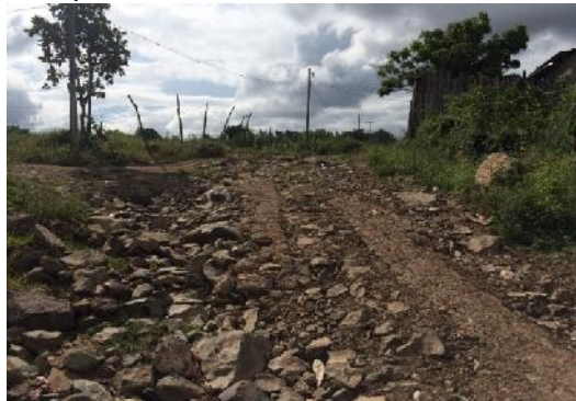
Panorama de calle donde se ejecutará la obra
