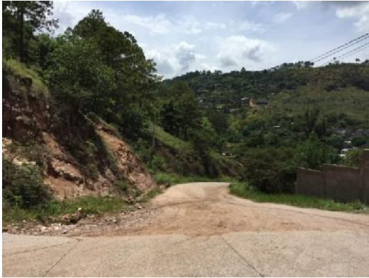
vista de calle en que se ejecutará la obra
