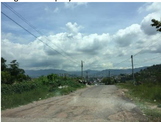
vista de inicio de obra a ejecutar
