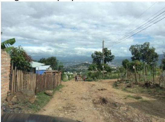
Calle donde se construirán las cunetas de mampostería
