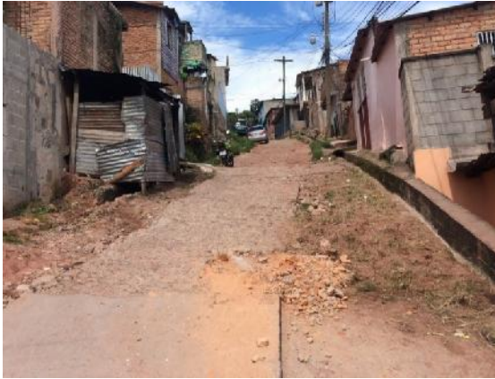
Se observa el estado actual de la calle
