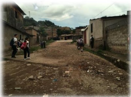
vista de calle a pavimentar. tramo B
