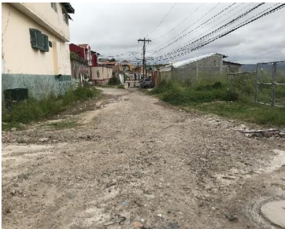
estado tramo II
