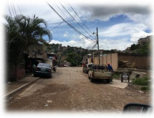
inicio de White topping. tramo C
