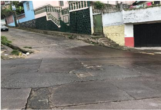
Proyecto: bacheo con concreto hidráulico, barrio El Bosque y Buenos Aires.
