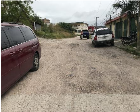
Estado Actual Tramo I
