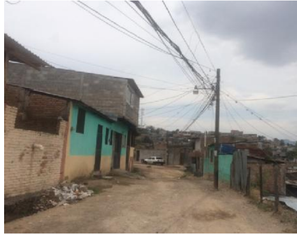
En la imagen se muestra un tramo intermedio de la calle a pavimentar
