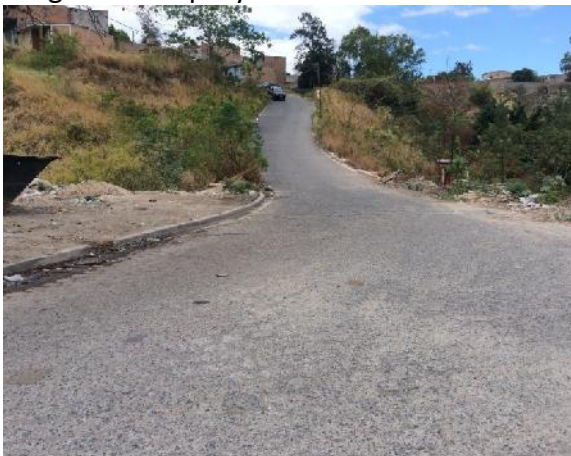
INICIO DE CALLE EN QUE SE DESMONTARÁ ADOQUÍN Y SE PAVIMENTARÁ CON CONCRETO HIDRÁULICO
