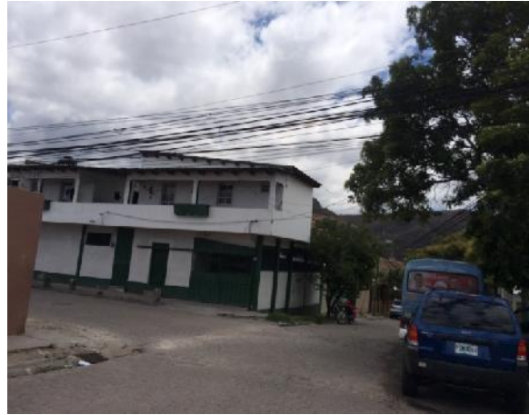
FINAL DE CALLE A PAVIMENTAR CON CONCRETO HIDRÁULICO
