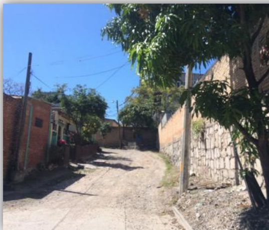
Inicio de calle "A"
