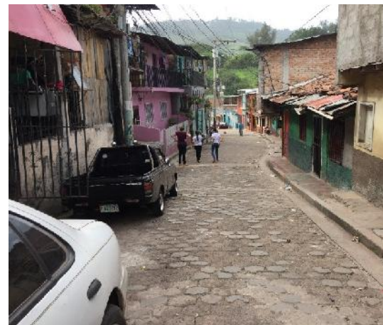
SE OBSERVAN LAS MALAS CONDICIONES DEL ADOQUINADO EXISTENTE
