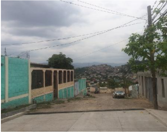
inicio de calle a pavimentar
