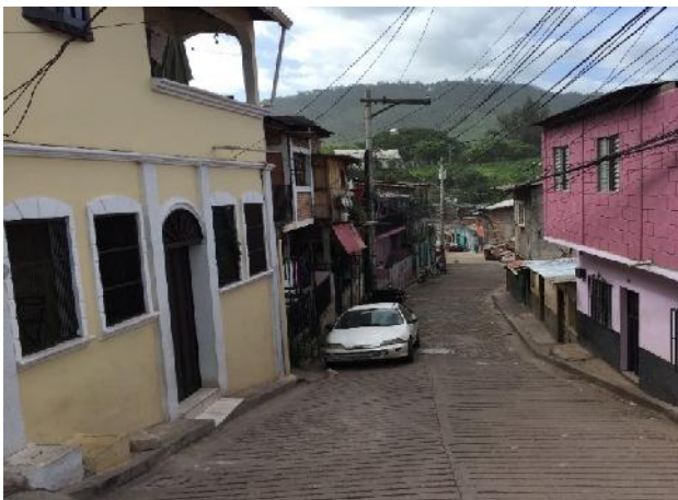
PANORAMA DE CALLE A PAVIMENTAR CON CONCRETO HIDRAULICO, CALLE B
