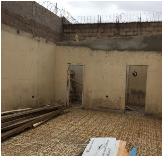
Vista de edificio existente.
