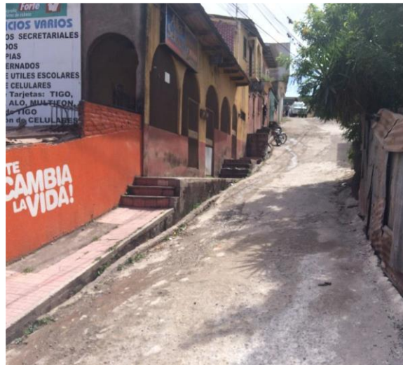
Tramo de calle donde se va a construir el White topping.
