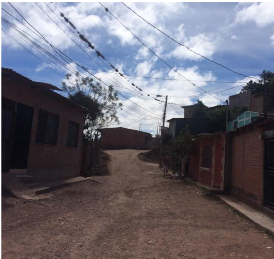
Vista de calle donde se ejecutará la obra.
