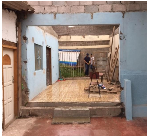
Ubicación en que se construirá la rampa para discapacitados.
