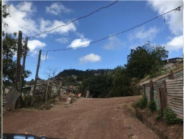
Calle donde se construirán las huellas.
