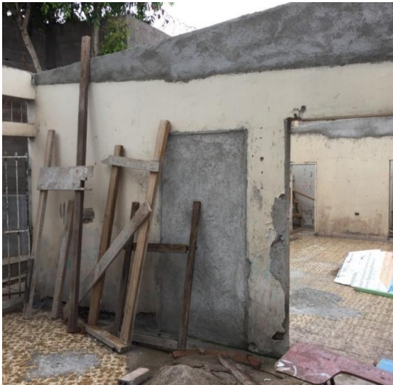
Situación existente en centro comunal de col. san miguel.
