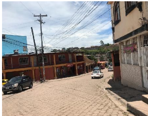
estado actual del adoquin que se desmontara
