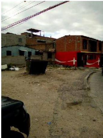
área para construir firme de concreto y pavimentar calles de tierra
