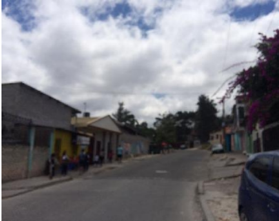
Inicio de calle a pavimentar
