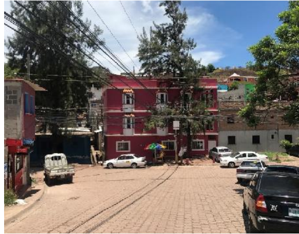
vista de final de la calle a pavimentar
