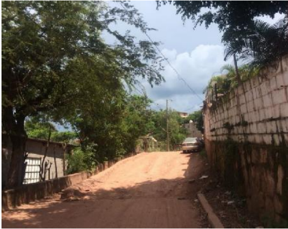
Vista de calle a pavimentar
