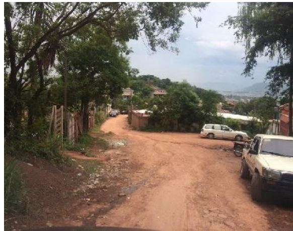
Vista panorámica de calle a pavimentar
