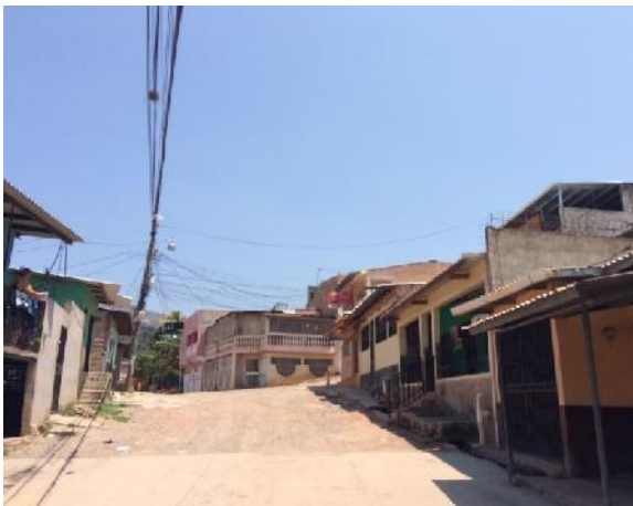
el tramo 3 de calle a ser pavimentada
