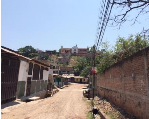
uno de los tramos a pavimentar que conecta con calle pavimentada
