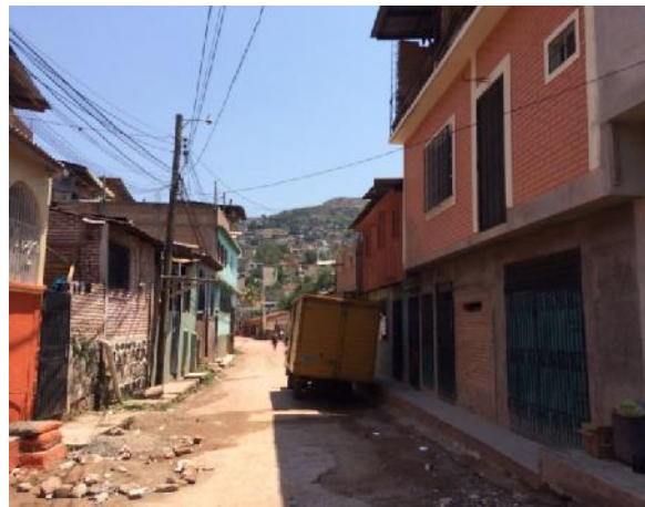
otro de los tramos a ser pavimentado
