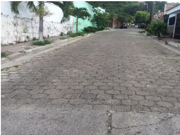
panorama de calle a pavimentar con concreto hidraulico
