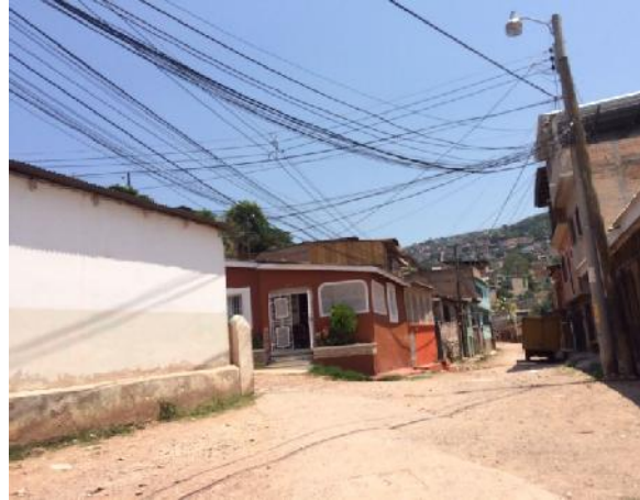
Tramo 2 de calle en mal estado a pavimentar
