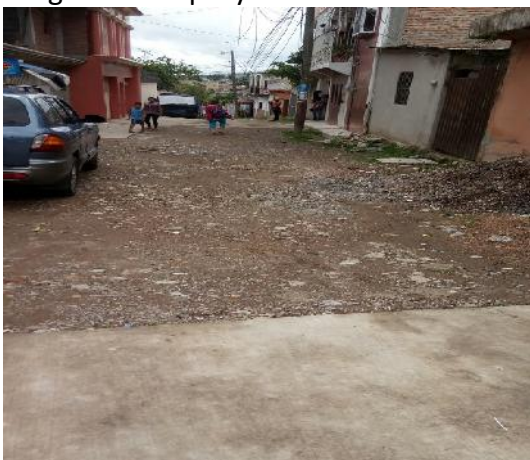
inicio de calle a pavimentar con concreto hidráulico
