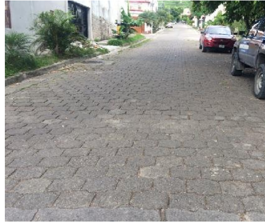
calle donde se desmontara el adoquin
