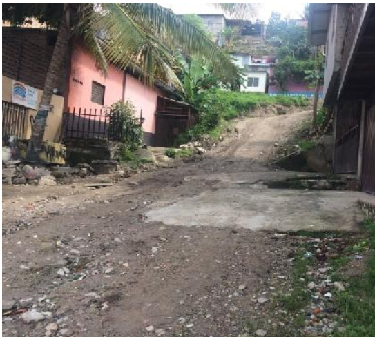
foto #3 condiciones actuales de la calle a pavimentar
