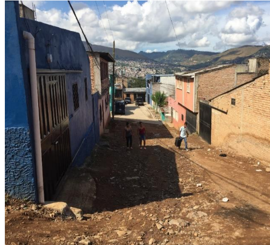
Final de calle a pavimentar con concreto Hidraulico.
