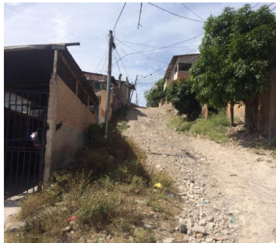
Final de obra a ejecutar.
