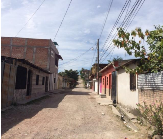
Vista de inicio de obra a ejecutar.
