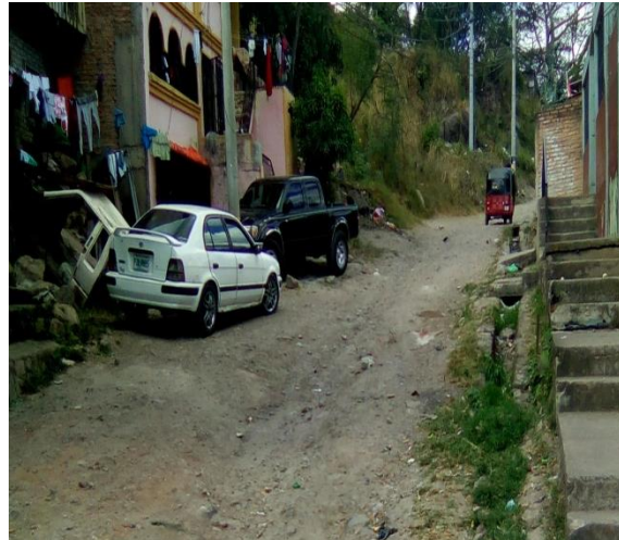
Panorama de calle en que se ejecutará la obra.
