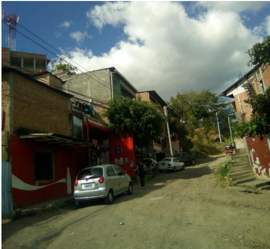
Vista de inicio de obra a ejecutar.
