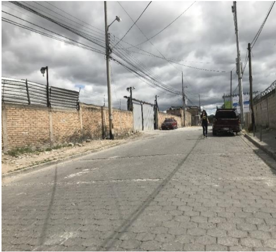
Vista de calle donde se desmontará el adoquín y se pavimentará con concreto hidráulico con espesor de 12 cm.
