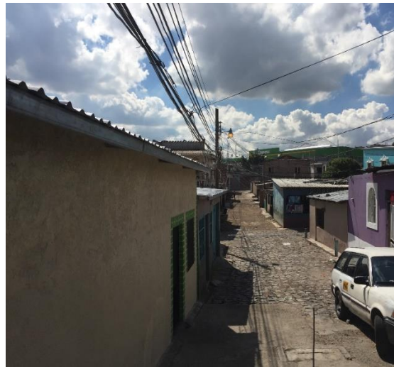
Panorama de calle a pavimentar con white topping.
