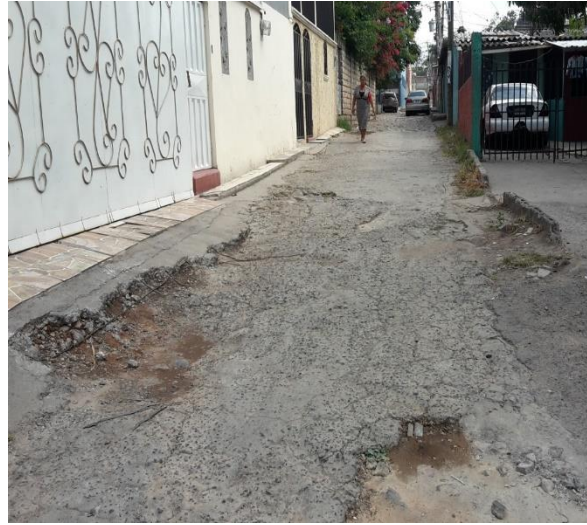
Panorama de calle a demoler para pavimentar nuevamente.
