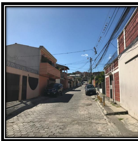
Vista de calle a pavimentar.
