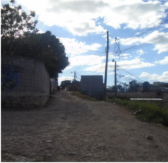
Vista de la calle a pavimentar con concreto hidráulico.
