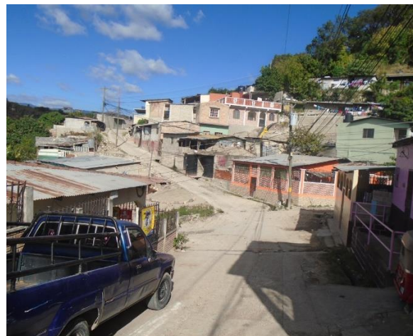
Estado actual de la calle donde se hará la demolición de elementos de concreto
