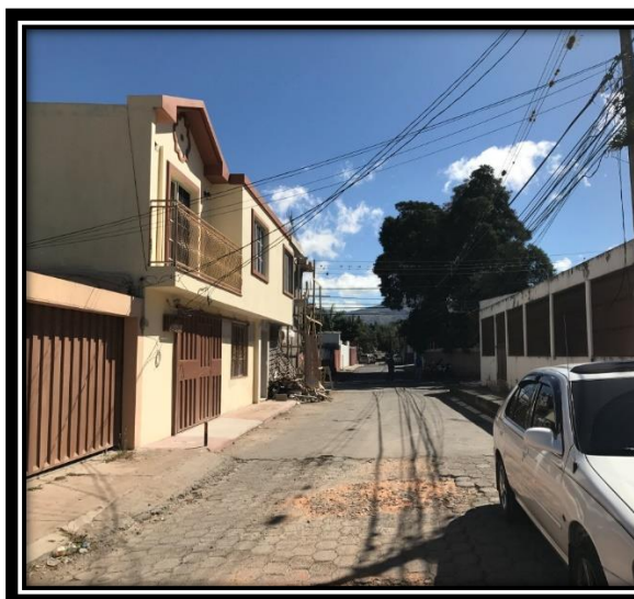
Final de calle a pavimentar.
