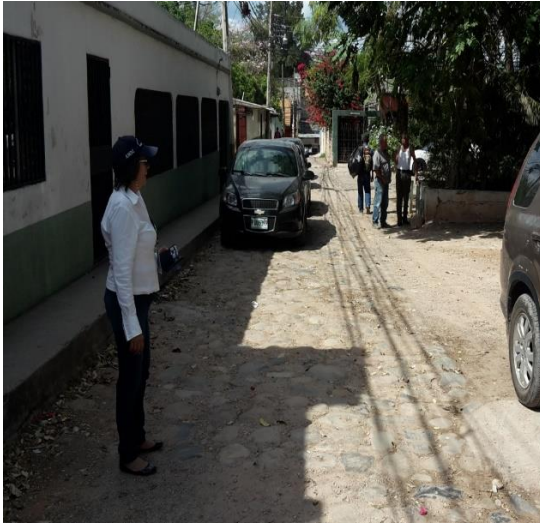
Vista de Calle a pavimentar con White topping.
