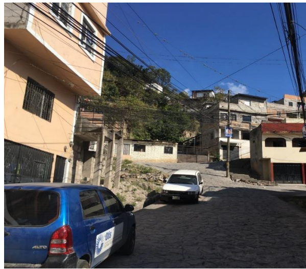
Vista de empedrado de calle a pavimentar con white topping.
