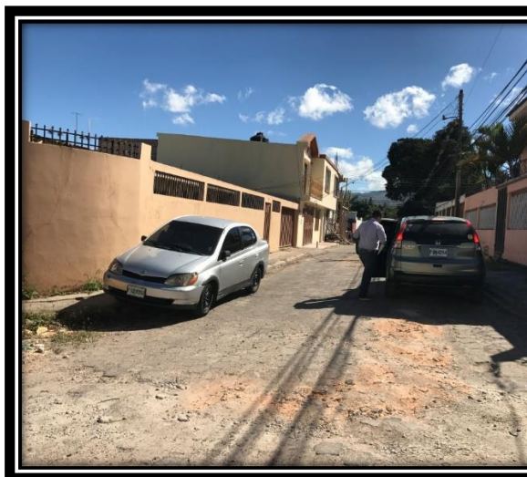
Panorama de calle en que se desmontará el adoquín.
