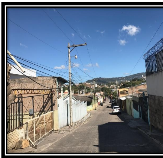
Vista de inicio de obra a ejecutar.
