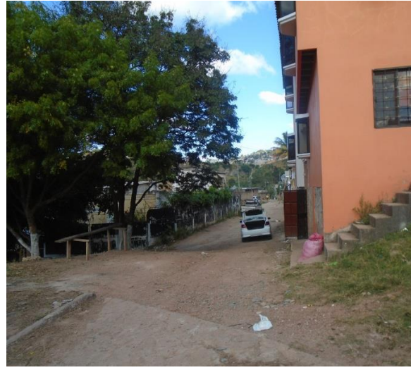
Final de la calle a pavimentar con concreto hidráulico.
