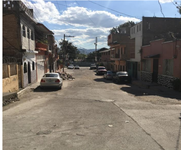
Panorama de calle que se demolerá calzada existente.
