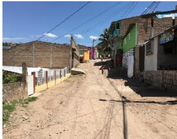
vista panorámica de calle a pavimentar
