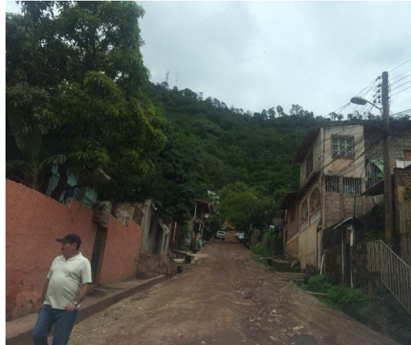
Se observa la pendiente del terreno, cunetas de drenaje en ambos lados de la calle.
