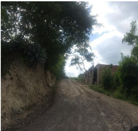
Inicio de calle en que se construirán huellas vehiculares.
