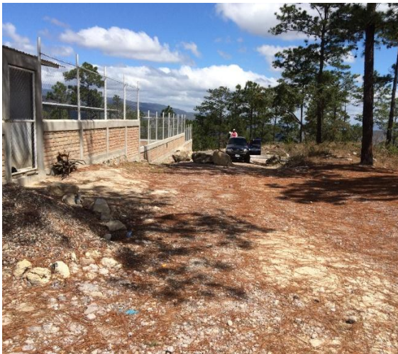
Inicio de calle donde se construirán huellas.
