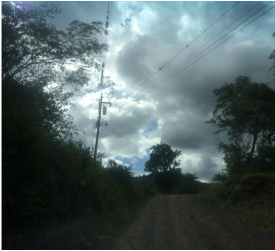
Panorama de la calle a pavimentar .
