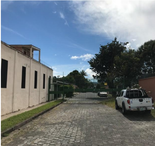
Vista de calle a pavimentar.
