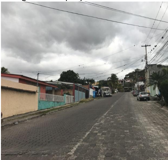
Vista de inicio de obra a ejecutar.
