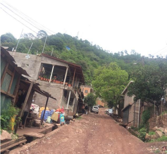
Se observa el estado actual, la pendiente del terreno y cunetas de drenaje de aguas lluvias en ambos lados de la calle.
