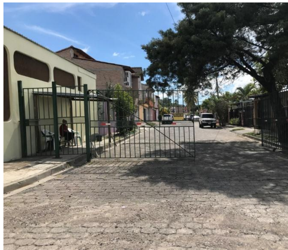
Panorama de calle en que se desmontará el adoquín.
