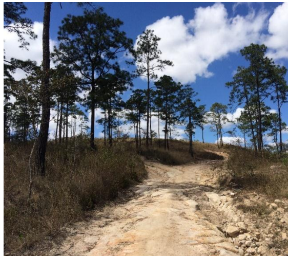
Vista de estado actual de la calle.
