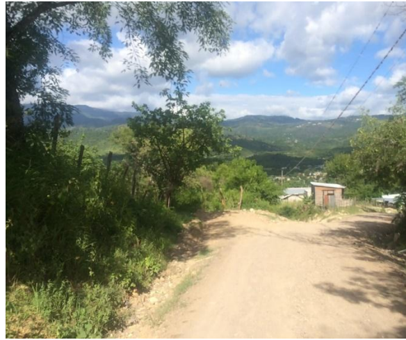
Final de calle en que se ejecutará la obra en aldea la cienega.
