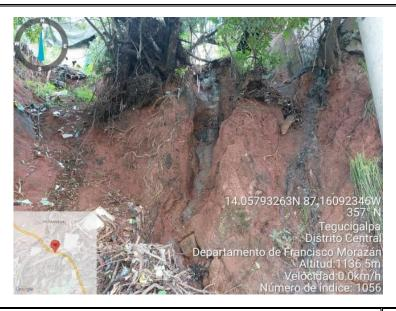
No.4 Actividad: Se observa la presencia de humedad por escorrentías superficiales que saturan y erosionan el talud, acelerando el desprendimiento de bloques.
