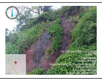
No.5 Actividad: Se observa la presencia de humedad por escorrentías superficiales que saturan y erosionan el talud, acelerando el desprendimiento de bloques.
