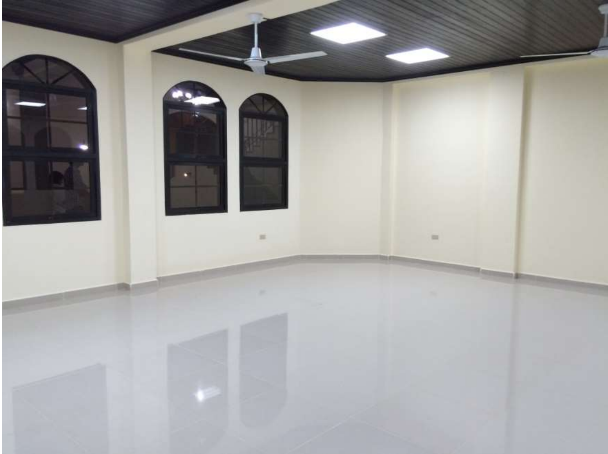
Cielo falso de primera planta, incluye luminarias y ventilador
