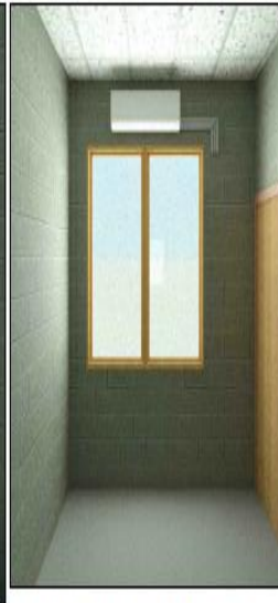
Vista de la Instalación de la Unidad Evaporadora Tipo Pared.
