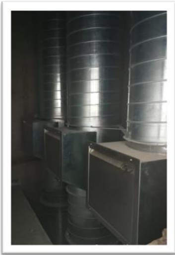
Fig. 1. Ductos de las basuras en el Edificio 1847
