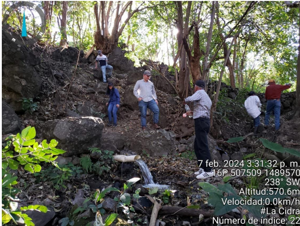
Sítio de Obra de Toma La Sidra
